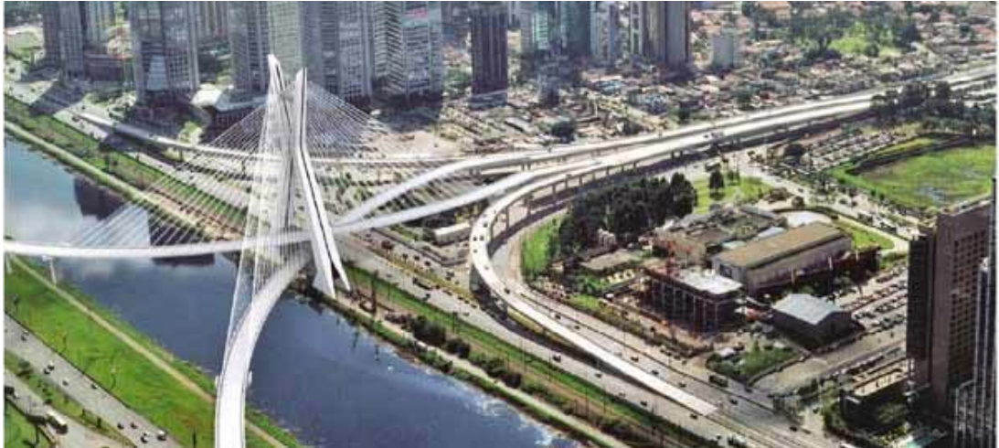
Figura 20: Ponte Estaiada Octavio Frias de Oliveira Fonte: Skyscrapercity, 2010
