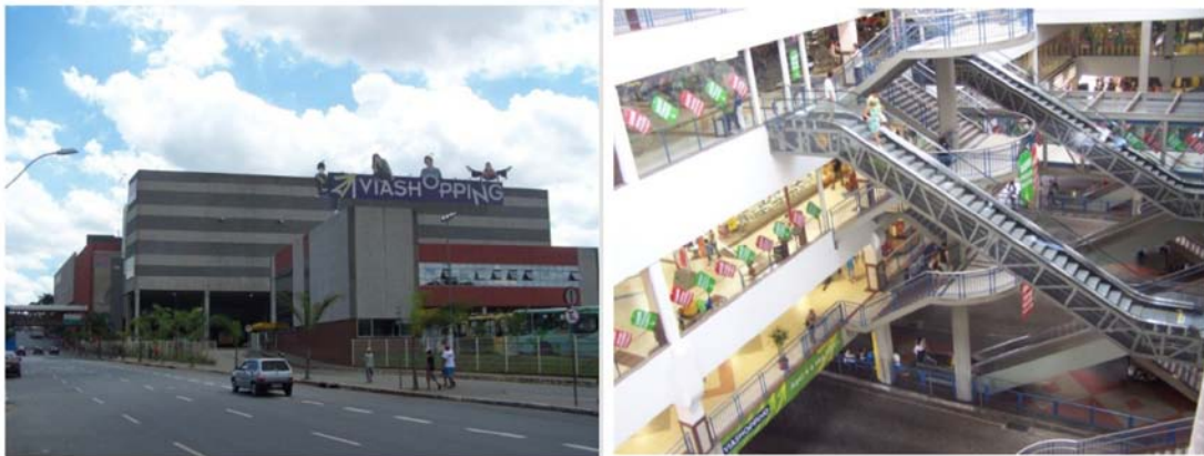
Figura 7: Estação BHBUS – Barreiro – Foto Externa e Interna Fonte: Webshots, 2010
