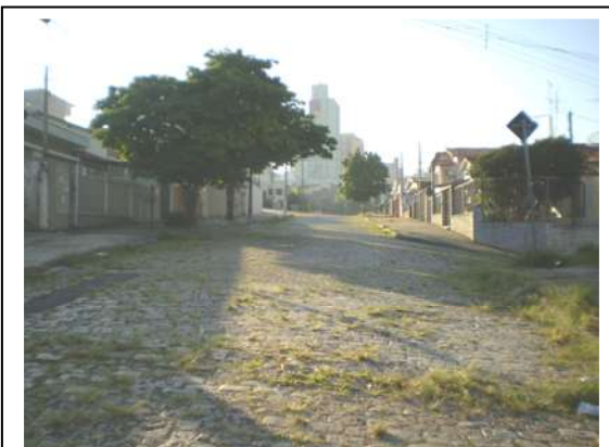
Figura 24 – Vista geral Área 4 Rua 24 de Maio com Rua Monteiro Lobato Arquivo pessoal – 12 de maio de 2008.
