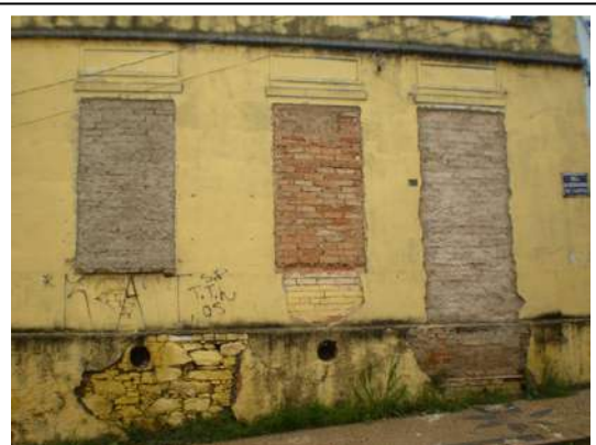
Figura 44 – Edificação abandonada com aberturas vedadas
