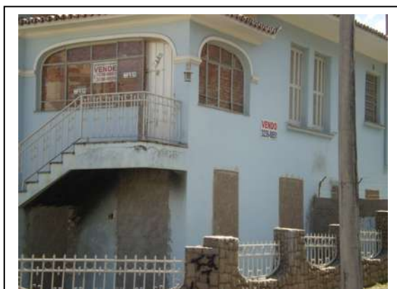
Figura 20 – Edifício à venda, com destaque as aberturas vedadas
