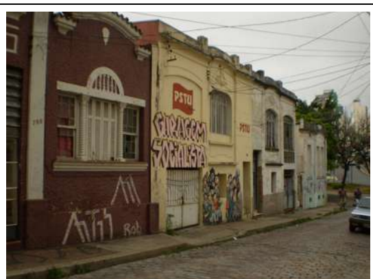
Figura 33 – Conjunto arquitetônico (imóveis tendo uso habitacional coletivo)
