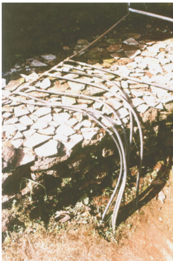
Foto 3.15 Sistema construído por um morador para receber a água da mina e distribuí-la.
