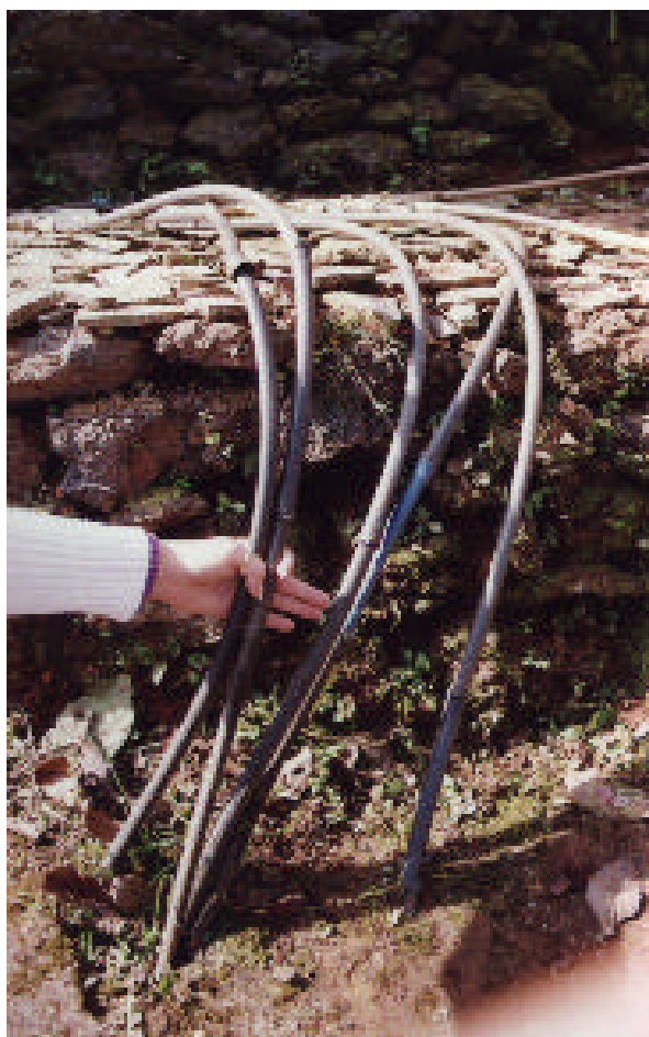
Foto 3.14: Caminho da água para reservatório domiciliar.
