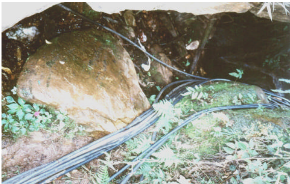
Foto 3.10: Mangueiras na saída de uma mina (Morro Santana).
