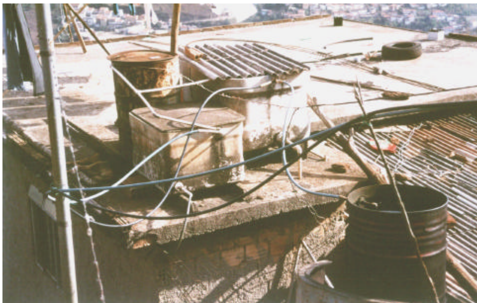
Foto 3.12: Forma como a água chega aos domicílios.
