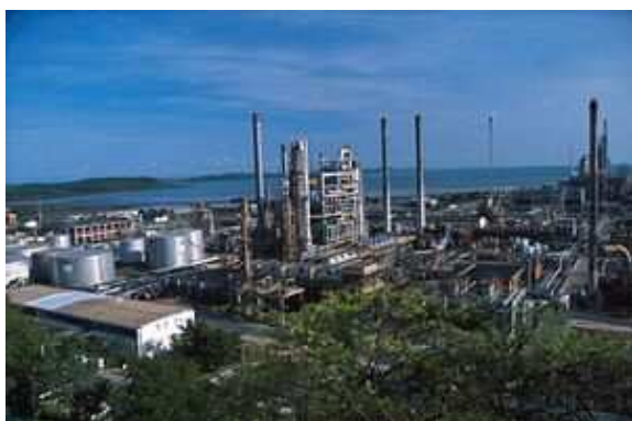
Figura 5. Área operacional da refinaria
