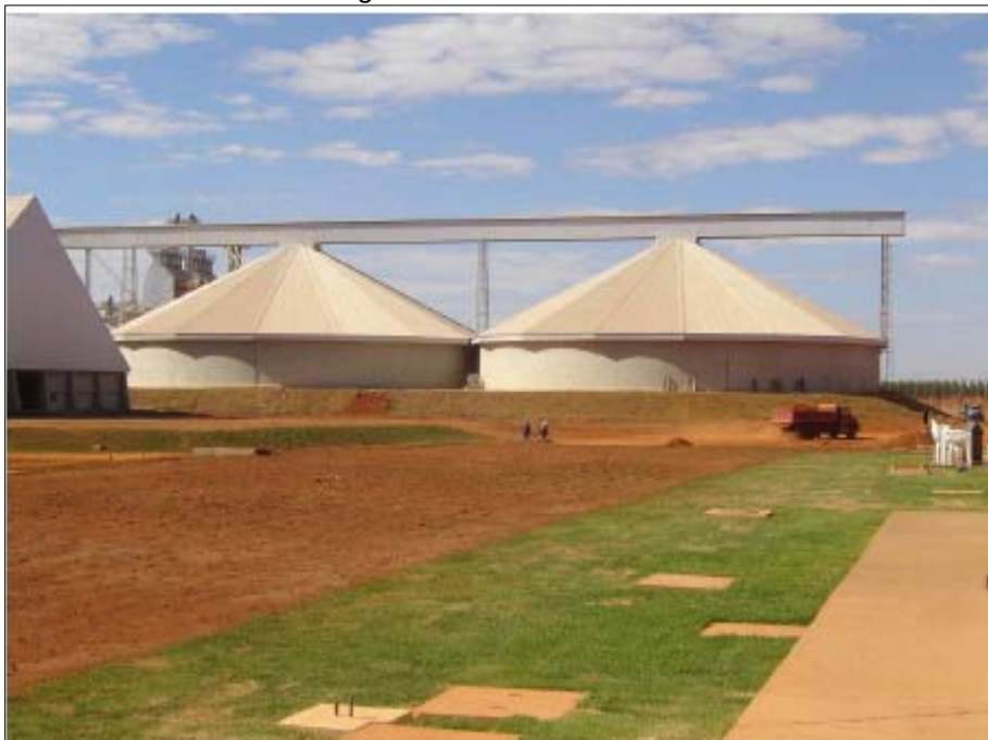
Foto 2 - Silos de armazenagem da Sadia
