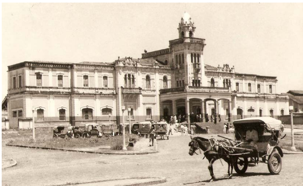
Foto 20 - Araguari (MG): estação da Estrada de Ferro Goiás (1940)
