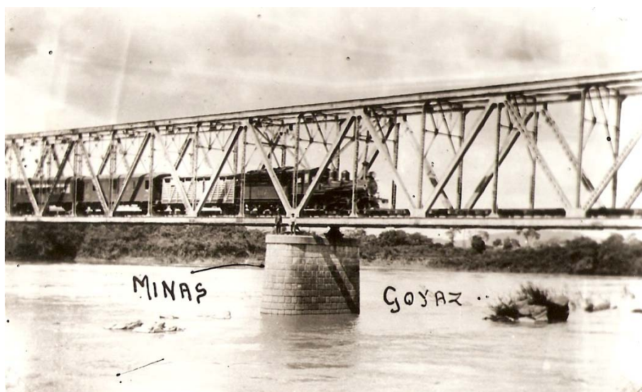
Foto 16 - Araguari (MG): Ponte pênsil metálica “Afonso Pena” (1913) Fonte: Arquivo Histórico e Museu Dr. Calil Porto (2009)
