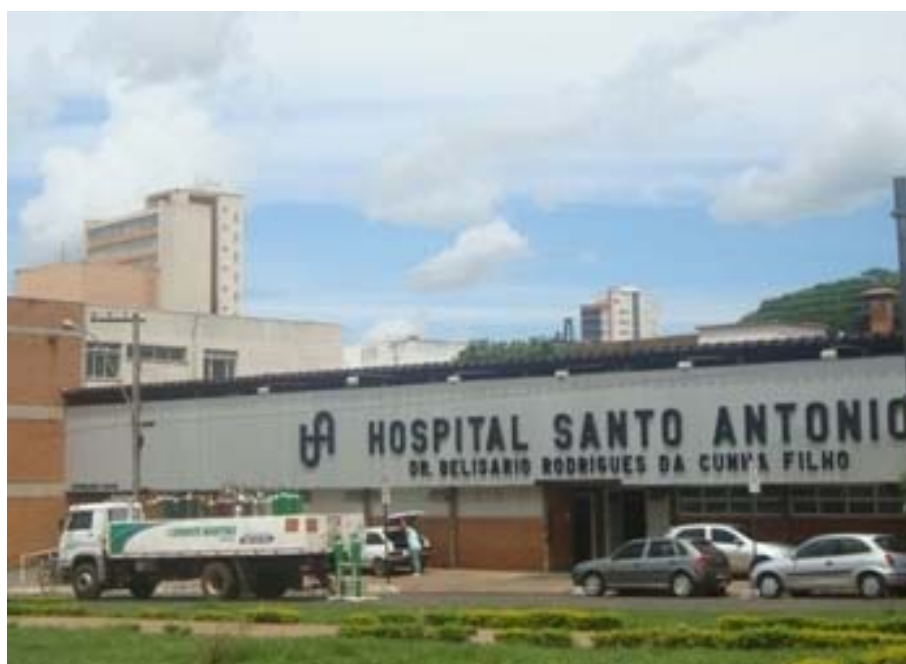
Foto 43 - Araguari (MG): Hospital Santo Antônio (2009)
