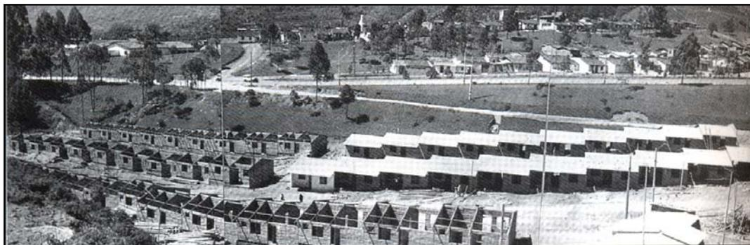
**Fig. 96** – Colocação da estrutura de cobertura das *Viviendas*. Apesar de a estratégia de aproveitamento do espaço de construção ser hoje bastante questionável, o processo construtivo tem se mostrado bem resolvido. Colômbia, 1987. (fonte: HIDALGO-LÓPEZ, 2003, 282).
