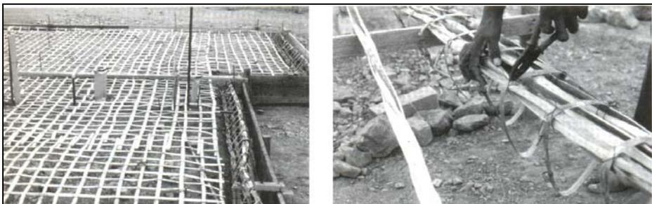
**Fig. 80a e b** - Malha de guadua (*bamboo mesh*) cobrindo a superfície da casa (esq.) e detalhe de fixação das fitas no estribo triangular formando as vigas de periféricas de bambu (dir.). (fonte: HIDALGO-LÓPEZ, 2003, 271).
