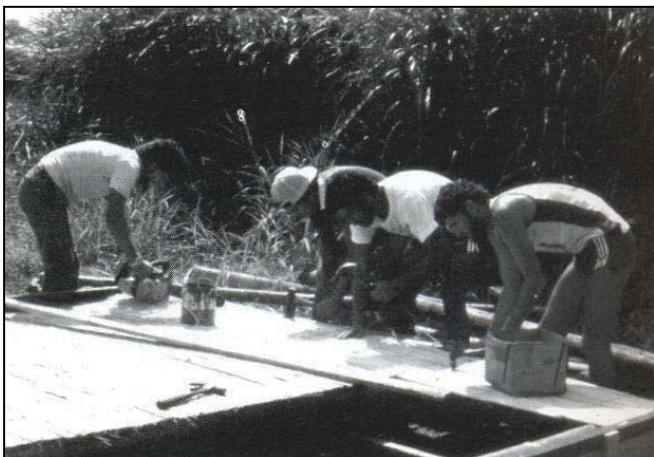
**Fig. 89** – Pré-fabricação das paredes de Guadua, Costa Rica, 1984. (HIDALGO-LÓPEZ, 2003, 280).
