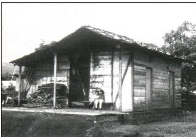
**Fig. 87** – Todas as paredes construídas com pequenas placas de madeira conjugada – *wood boards*. (fonte: HIDALGO-LÓPEZ, 2003, 279).
