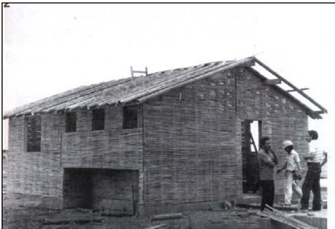
**Fig. 84** – Finalização da casa com a colocação da estrutura de cobertura. (fonte: HIDALGO-LÓPEZ, 2003, 277).
