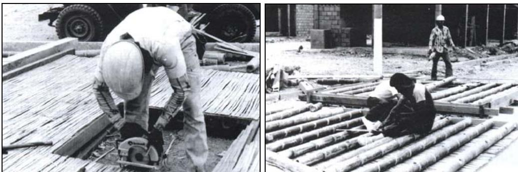
**Fig. 76a e b** – Manufatura da parede de Guadua (*bamboo board*) e acabamento com serra circular manual. (fonte: HIDALGO-LOPEZ, 2003, 270).
