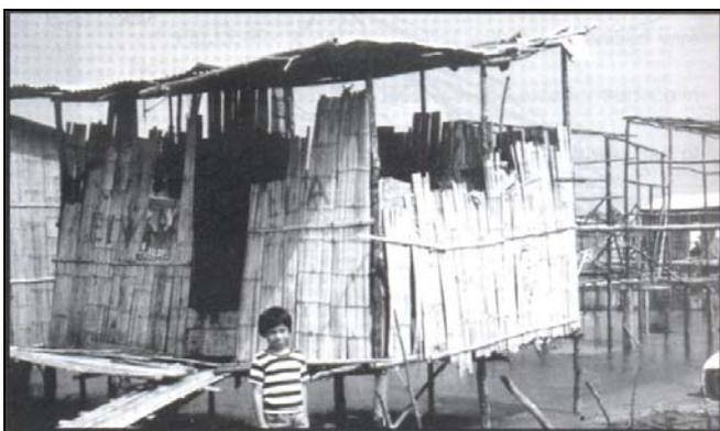
**Fig. 78** – Abrigo provisório, bambu e madeira. Zona pobre de Guayaquil, Equador, década de 1980. (HIDALGO-LÓPEZ, 2003, 264).
