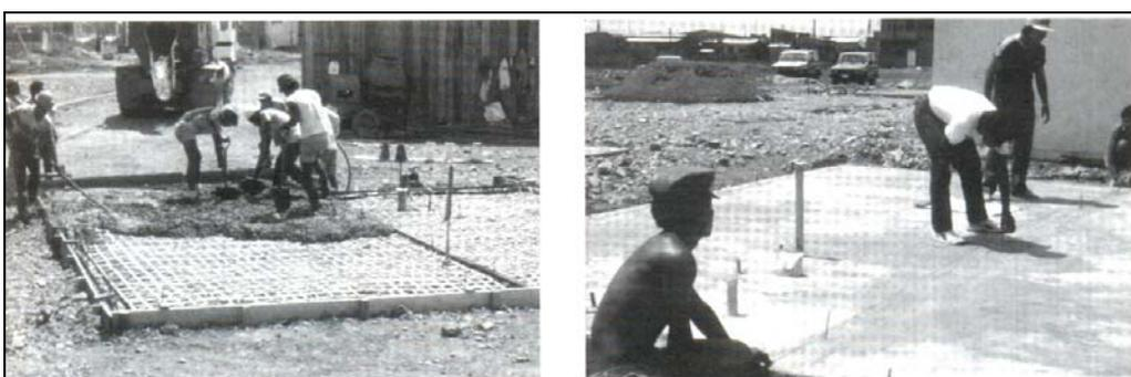
**Fig. 82a e b** - Aplicação do concreto na laje de fundação (esq.) e marcação das linhas de localização das paredes. (fonte: HIDALGO-LÓPEZ, 2003, 271).
