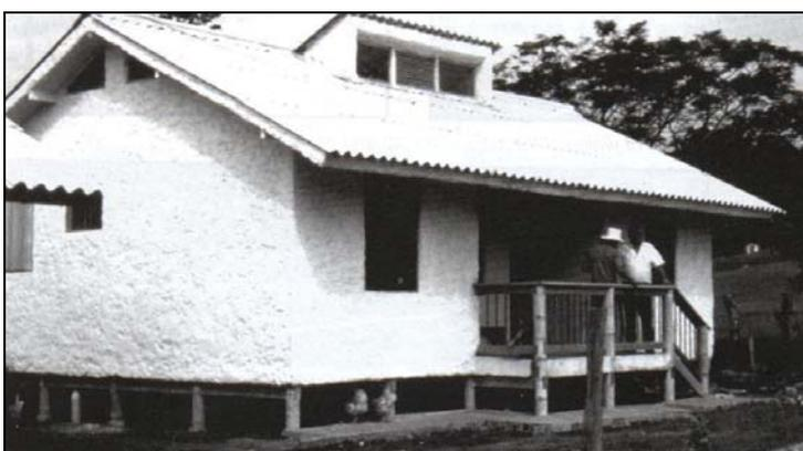
**Fig. 94** – Estrutura em bambu e madeira elevada do chão. Colômbia, 1985. (fonte: HIDALGO-LÓPEZ, 2003, 281).
