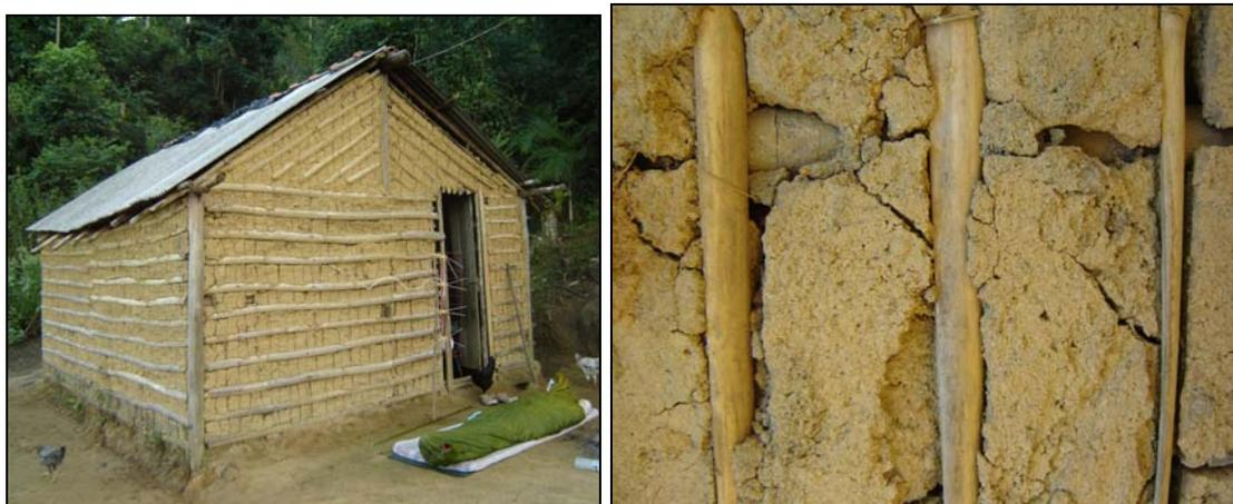
**Fig. 59 e 60-** À esquerda, casa de pau a pique híbrida: parede de barro, madeira e bambu, e cobertura de amianto. À direita, incorporação do bambu à estrutura da habitação Aldeia Sapucaí, Bracuí, 2007. (Arquivo pessoal).
