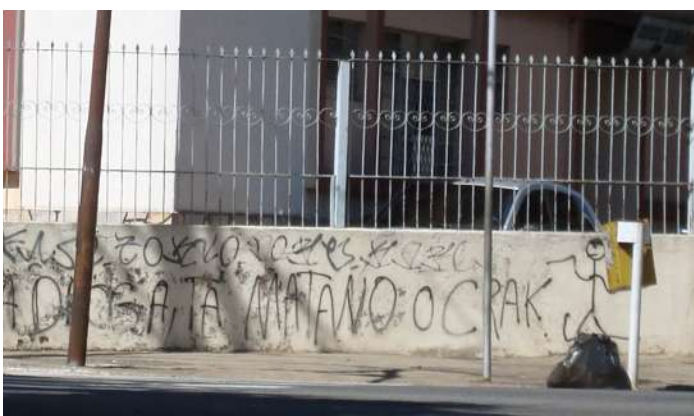
7 – Crack tá matano p.6
