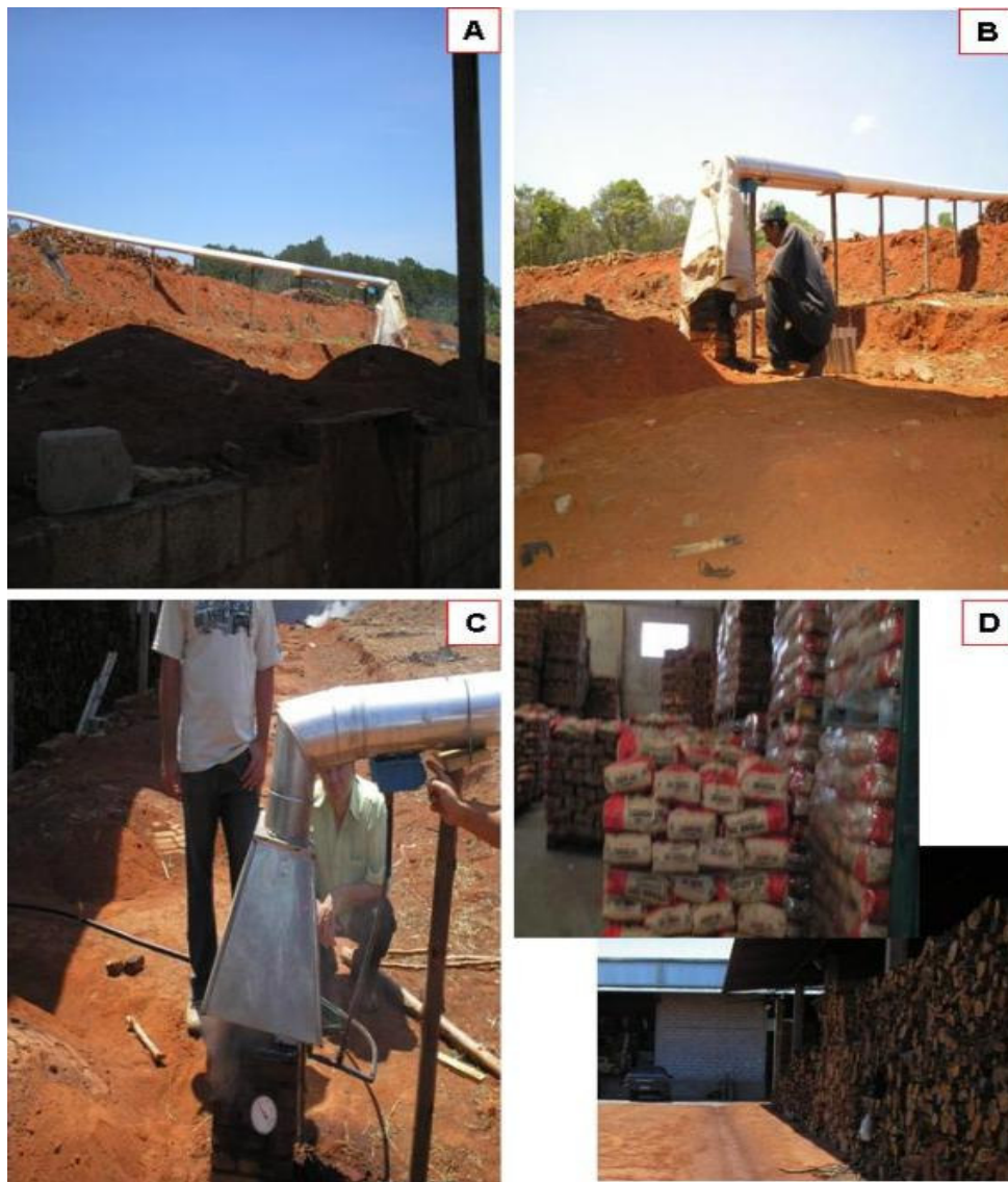
Figura 2. Processo tecnificado para obtenção de carvão vegetal e extrato pirolenhoso (EP) de qualidade. A: Forno de encosta e tubulação para processo de condensação da fumaça (36 m); B: Controle da temperatura na saída da primeira chaminé do forno e captação da fumaça; C: Coleta do EP (bruto) e D: Carvão vegetal pronto para uso. Fonte: Fernando Sá (Adaptado por SILVEIRA, 2010).
