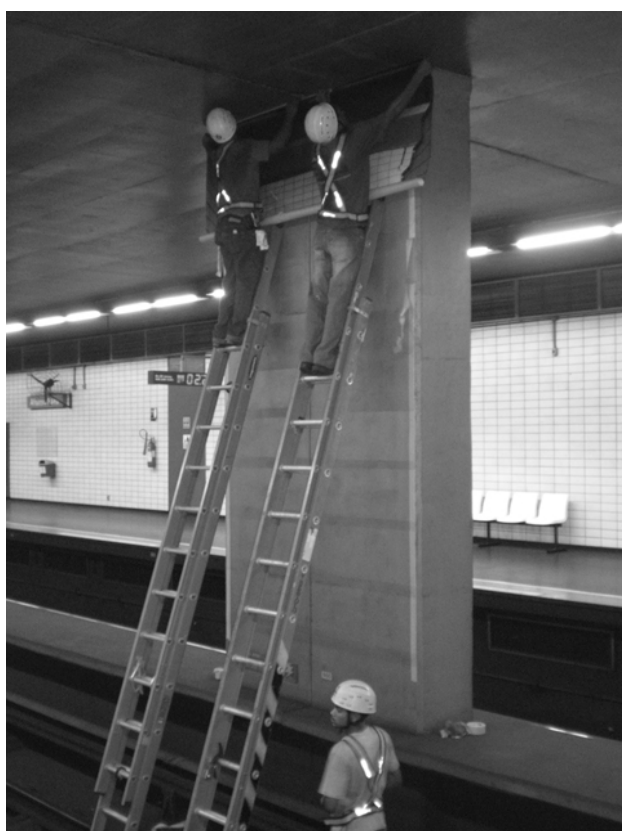
Ilustração 2. Fixação das intervenções na pilastra divisória central.
