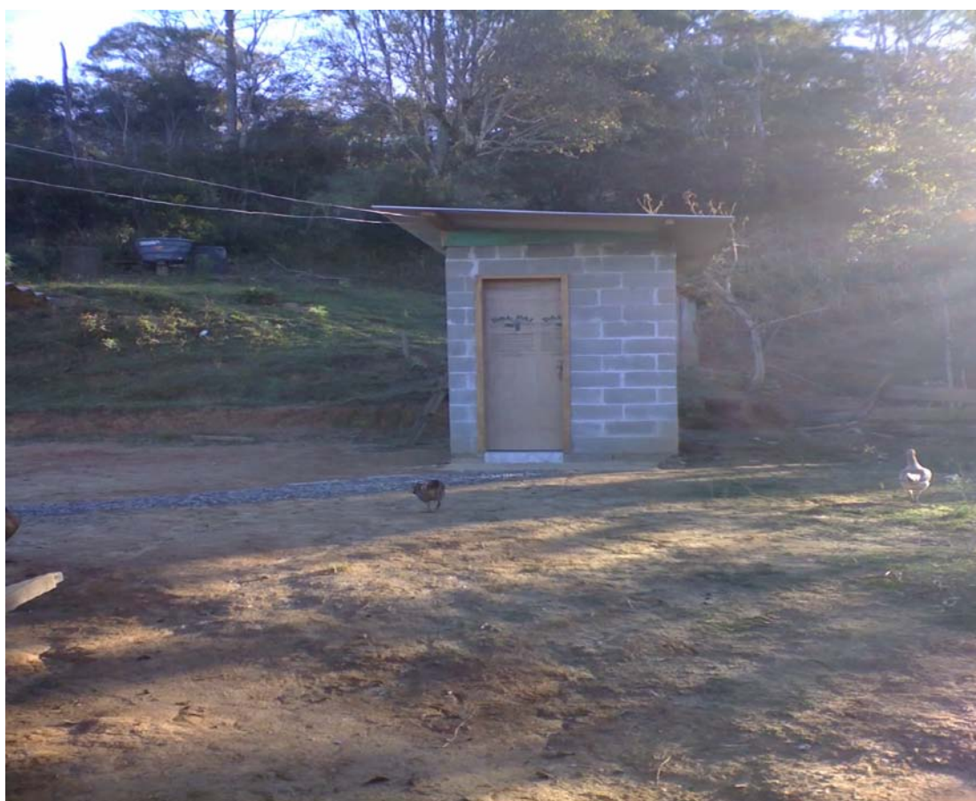
FOTO 9 – Reformas realizadas a partir do crédito do PRONAF, construção de banheiro no município de Itaperuçu.
