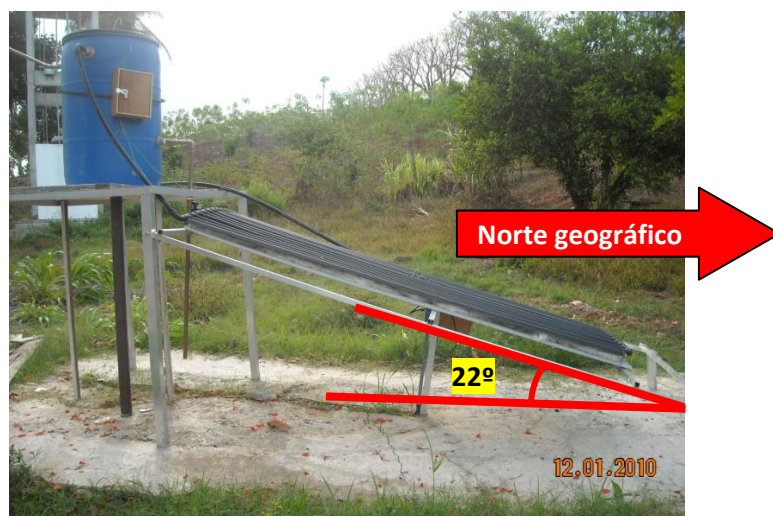
Figura 3.20. Orientação geográfica do coletor em estudo
