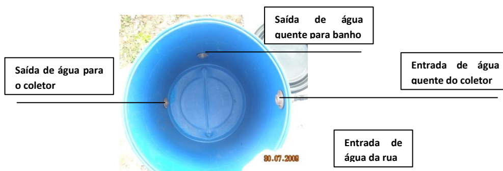
Figura 3.12. Detalhe dos furos vistos internamente.
