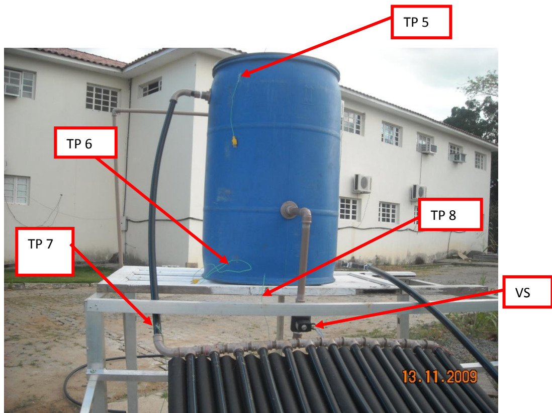
Figura 3.17 Detalhes da instalação dos termopares e da válvula solenóide.
