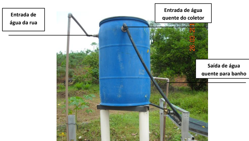
Figura 3.14. Detalhe dos furos no reservatório, vistos lateralmente.
