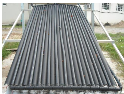
Figura 3.10. Detalhe das conexões de PVC pintadas de preto fosco.
