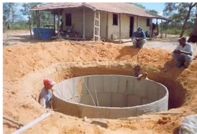
Fig. 19 - Cisterna em construção Fonte: prefeituraboavista.blogspot.com/2009/12/prefe
