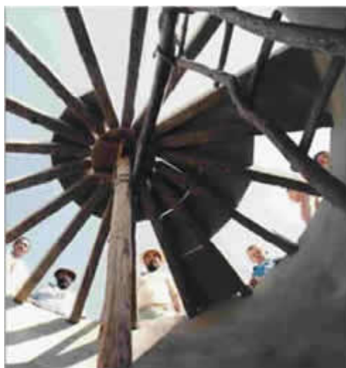
Fig. 17 - Estrutura da Cisterna Fonte: www.fazfacil.com.br/reforma_construcao/cisternas_4.html
