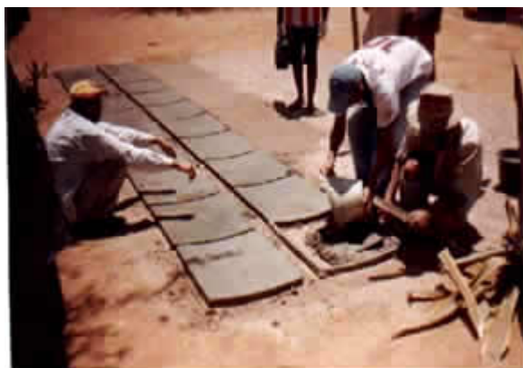
Fig. 15 - Cisterna de placas de cimento
