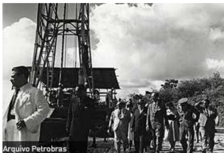
Figura 03: Instalação da Petrobras - 1954
