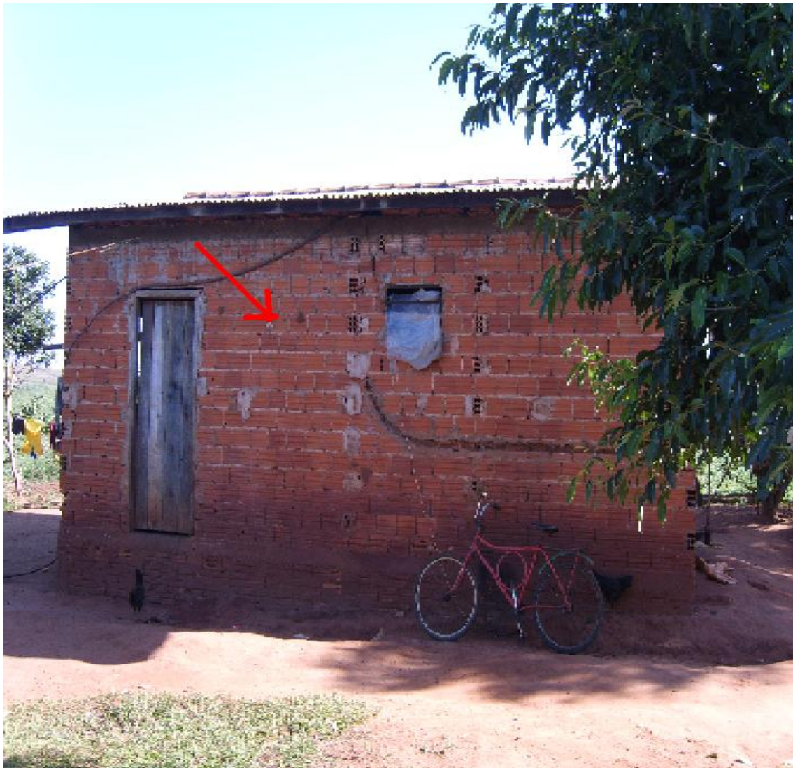
Figura 18: Paiol transformado em residência e sem nenhuma melhoria – Foto:L.F.M.B. (2009)
