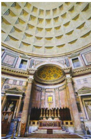
Figura 1.1: Vista da cúpula de concreto do Panteão Romano (Pedroso, 2009).
