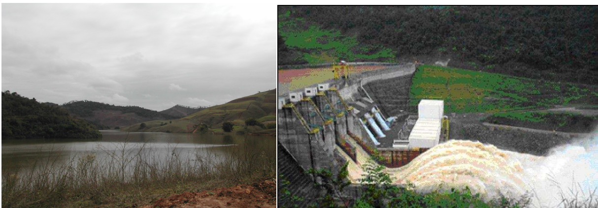
Figura 3: Usina hidrelétrica de Candonga (a: lago da usina; b: barragem da usina hidrelétrica de Candonga; Fonte: Construtora OAS)
