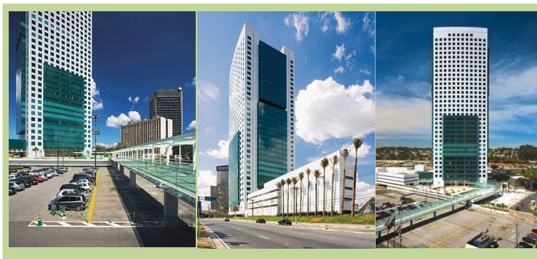
Figura 16: Vistas do Eldorado Business Tower Fonte: (ARCOWEB, 2008)
