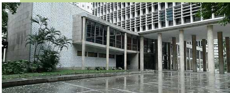
Figura 11: Vista do acesso e pilotis do edifício Palácio Gustavo Capanema
