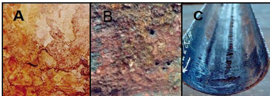
Figura 2 – Corrosão (A) uniforme; (B) uniforme e pitiforme; (C) Alveolar [7].
