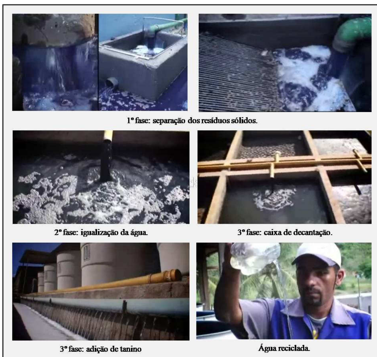
Figura 26: Sistema de Reciclagem de Efluentes da Lavanderia Mamute.
