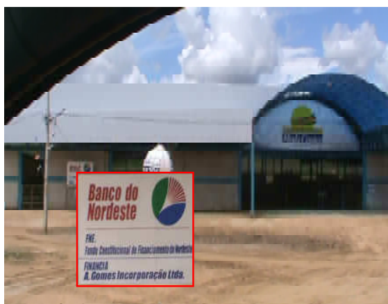
Figura 18: Centro de Comercialização Agamenon Moda Center em construção.
