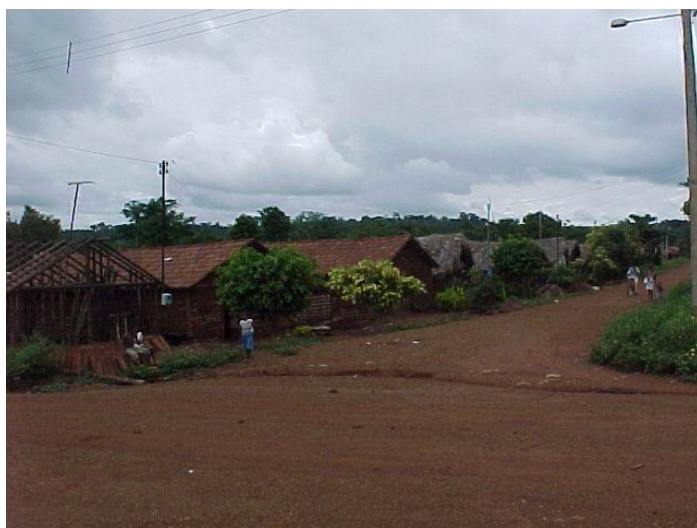
Figura 17: Foto de construções precárias (na área junto ao rio Tocantins, na parte mais baixa da cidade) Fonte: Plano Diretor de Desenvolvimento Sustentável de Aguiarnópolis
