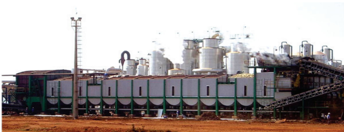
Figura 2.13: Difusor da Usina Vertente com capacidade de 10.000 t de cana por dia. (Fonte: UNI-SYSTEMS).
