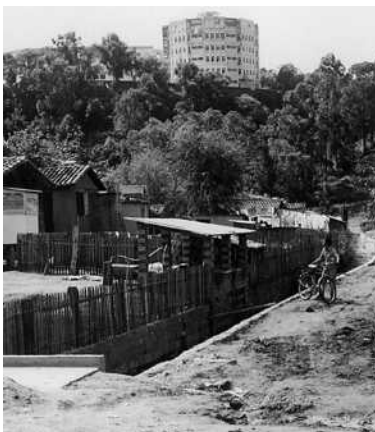
Figura 4.10: Vista parcial da canalização dos rios de primeira ordem nas encostas do Morro Cechinel, Bairro Cruzeiro do Sul, com contenção de margem e de fundo. Acervo: Casa da Cultura de Criciúma, 1981.
