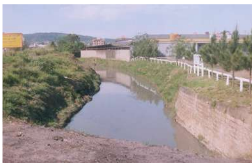
Figura 4.24: Vista parcial do rio Criciúma retelinizado, mas sem contenção de margem e de fundo, localizado no bairro Santo Antônio. Acervo: Rose Maria Adami e Yasmine Moura da Cunha, 2004.
