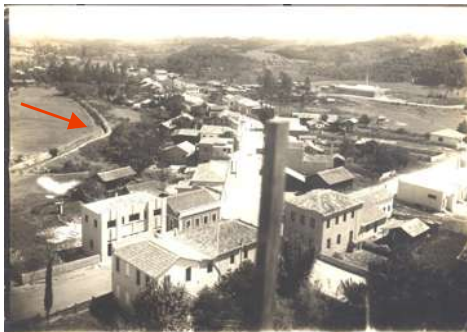
Figura 2.09: Vista parcial do canal construído pelo Sr. Benjamim Bristot para desviar água do rio Criciúma, nos anos de 1940. A água desviada servia para tocar a roda d’água que gerava energia para o engenho. Percebe-se a esquerda da foto o canal que segue paralelo ao rio Criciúma junto a vegetação. Acervo: Foto cedida gentilmente por Dona Libera Sebastião.
