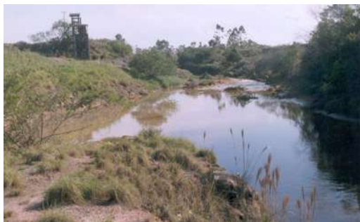
Figura 3.15: Vista parcial do lavador de carvão desativado da empresa de mineração Companhia Carbonífera Urussanga (CCU), no bairro Santa Augusta (Criciúma/SC). Acervo: Rose Maria Adami, em 2003.
