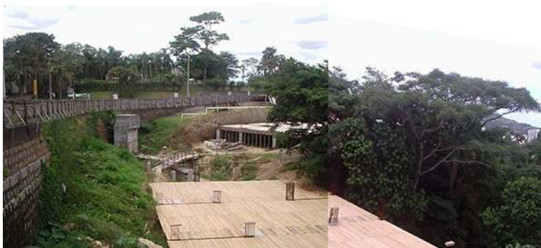
Figura 4.11: Vista da canalização de parte do afluente da margem direita formador do rio Criciúma, na rua Vidal Brasil. Acervo: Rose Maria Adami e Yasmine Moura da Cunha, 2004.
