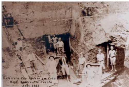
Figura 3.02: Vista parcial de uma das minas de encosta do Morro Cechinel, no bairro Pio Corrêa, em 1915, com duas galerias de extração. Criciúma (SC). Acervo: Arquivo Zapelini.
