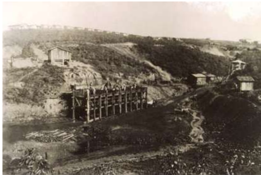
Figura 3.13: Vista parcial de uma mina localizada na encosta. Observa-se à direita da foto que as águas do interior das minas eram lançadas diretamente no solo e estas por sua vez certamente alcançariam os cursos d'água. Foto sem data e localização. Acervo: Casa da cultura de Criciúma.
