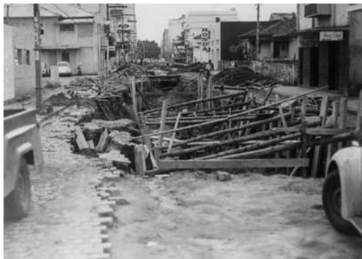
Figura 4.06: Vista parcial da construção do canal auxiliar do rio Criciúma na rua Marcos Rovaris, no ano de 1979. Acervo: casa da Cultura de Criciúma.
