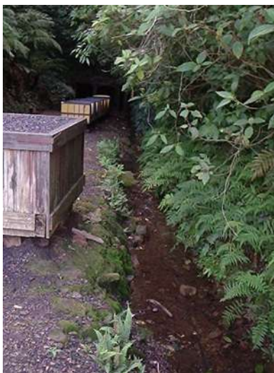
Figura 3.14: Vista parcial do canal que drena a água oriunda do interior da Mina Modelo Caetano Sônego (Criciúma/SC). Acervo: Rose Maria Adami, em 2003.
