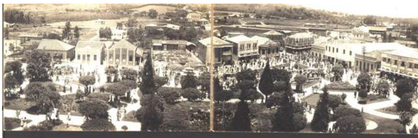
Figura 2.05: Vista parcial das residências localizadas no entorno da Praça Nereu Ramos, nos anos de 1940 e beneficiadas com água encanada. Acervo: Fotos cedidas gentilmente por Libera Napoleão.
