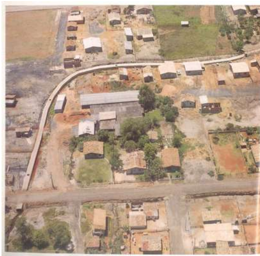
Figura 4.12: Vista da canalização de um curso d'água, da esquerda para a direita no alto da figura, com contenção de margem, de fundo e recobrimento superior pelo poder público. Acervo: Criciúma (1992).
