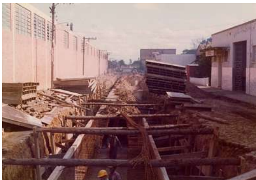
Figura 4.08: Vista parcial da construção do canal auxiliar do rio Criciúma na rua Araranguá, no ano de 1979. Acervo: casa da Cultura de Criciúma.
