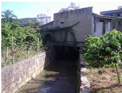
Figura 4.27: Vista parcial do aflente da margem direita do rio Criciúma com contenção de margem e de fundo. Ao fundo, depois de recobrirem o aflente, os moradores construíram uma casa sobre ele, na rua João Cechinel, no Centro da cidade. Acervo: Rose Maria Adami e Yasmine Moura da Cunha, 2004.
