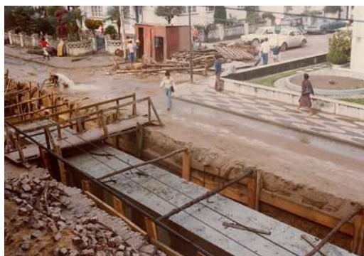
Figura 4.07: Vista parcial da construção do canal auxiliar do rio Criciúma na rua Getúlio Vargas, no ano de 1979. Acervo: casa da Cultura de Criciúma.
