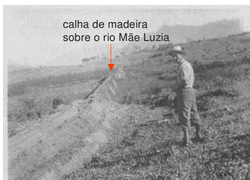
Figura 3.20: Vista parcial do canal de desvio do rio Guarapari que levava água para barragem por meio de calhas de madeira sobre o rio Mãe Luzia. Nova Veneza (SC). Acervo: Campos (2001).
