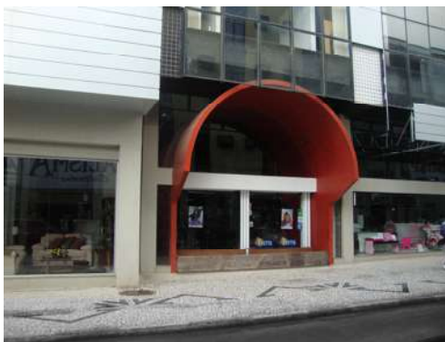
Figura 4.22: Vista de uma fachada com contenção móvel. Recurso muito utilizado pelos comerciantes na rua Cel. Pedro Benedet para contenção das águas de inundação. Acervo: Rose Maria Adami, 2010.
