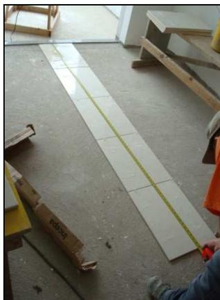
Figura 36 - Definição das fiadas de placas
