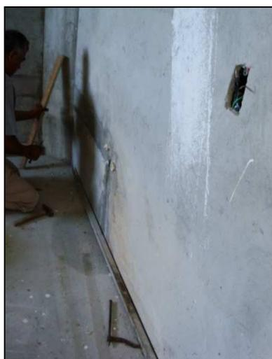
**Figura 14 - Marcação dos pontos de partida e chegada do assentamento**
