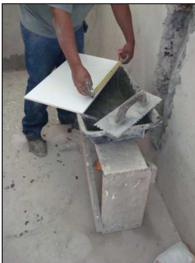
**Figura 21 - Medição e marcação do corte**
