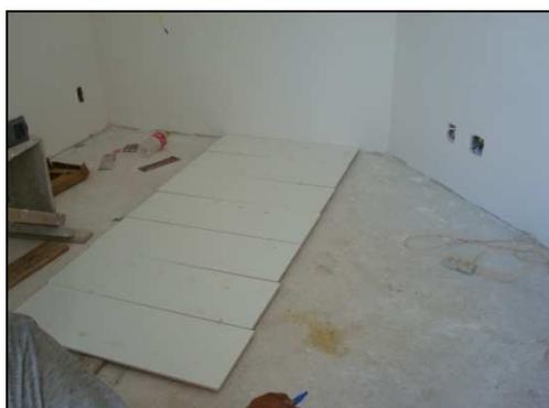
**Figura 18 - Placas sobre a régua de madeira**
