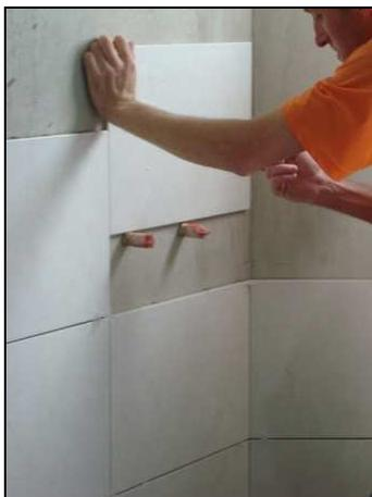
Figura 32 - Marcação de elementos hidráulicos
