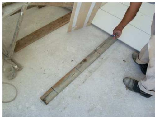
**Figura 17 - Marcação das alturas das placas na régua**
