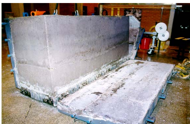
FIGURA 5.32 Desforma da Maciço Experimental
