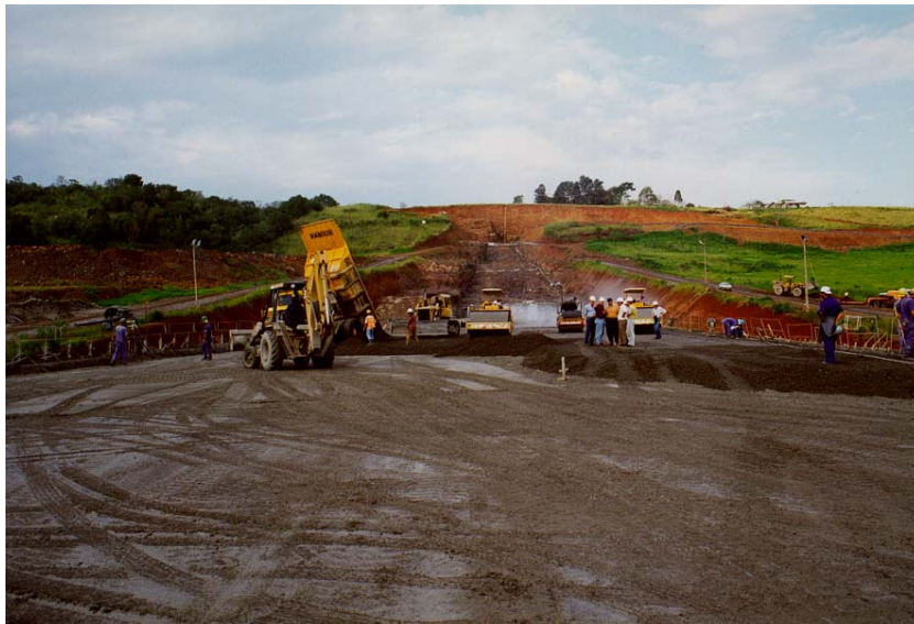
FIGURA 2.26 Vista Geral da Praça de CCR da UHE Salto Caxias
