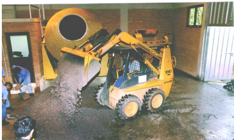
FIGURA 5.25 Homogeneização do CCR
