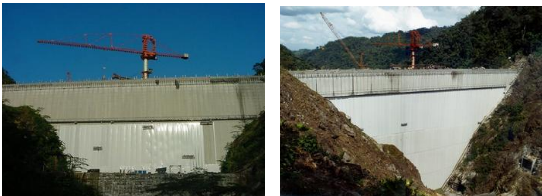
FIGURA 2.32 Instalação de Manta de PVC na Face de Montante de Miel I Fonte: SANTANA e CASTELL, 2004
