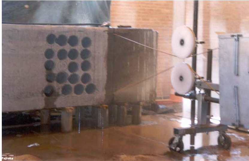
FIGURA 5.13 Corte com Serra de Fio Diamantado
