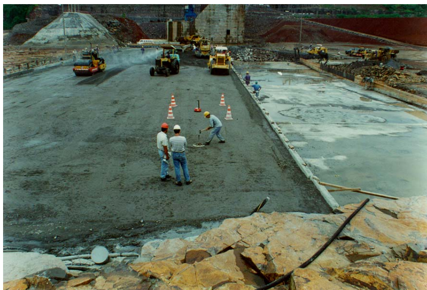
FIGURA 2.27 Vista Geral de Praça de CCR da UHE Salto Caxias– Em Primeiro Plano Utilização do Densímetro Nuclear
