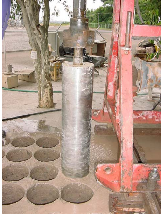
FIGURA 5.9 Detalhe do Início do Processo de Perfuração
