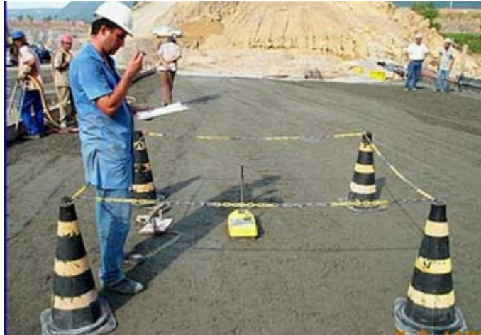
FIGURA 3.21 Utilização do Densímetro Nuclear - UHE Lajeado
