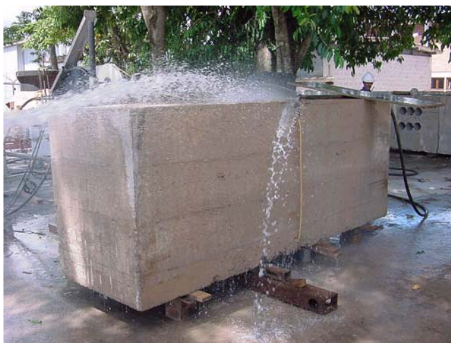
FIGURA 5.38 Corte com fio diamantado
