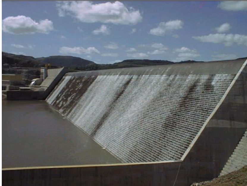
FIGURA 2.38 Face de Jusante com Vertedouro em Degraus da UHE Dona Francisca
