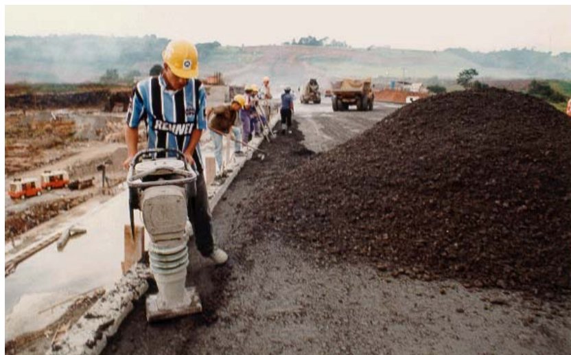
FIGURA 2.39 Maciço Experimental no Campo da UHE Salto Caxias
