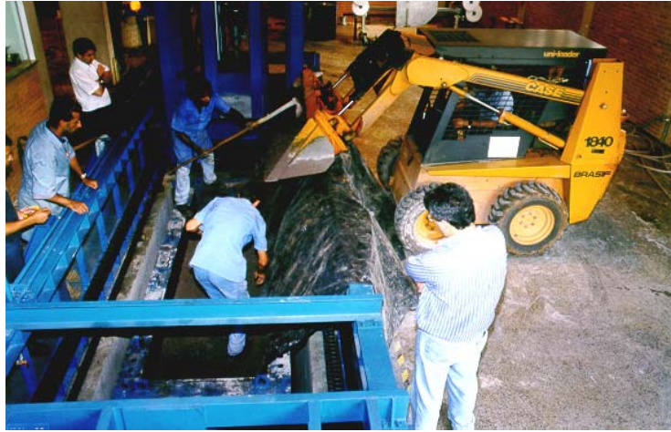
FIGURA 5.26 Lançamento e Espalhamento
