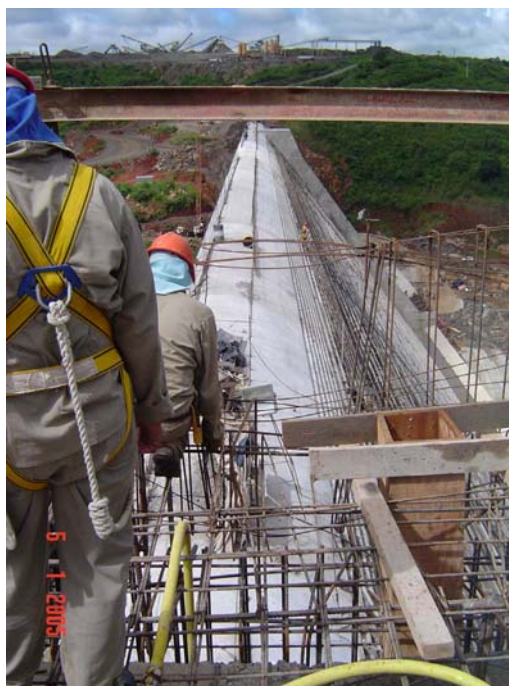
FIGURA 2.47 Face de Jusante da Barragem da UHE Santa Clara
