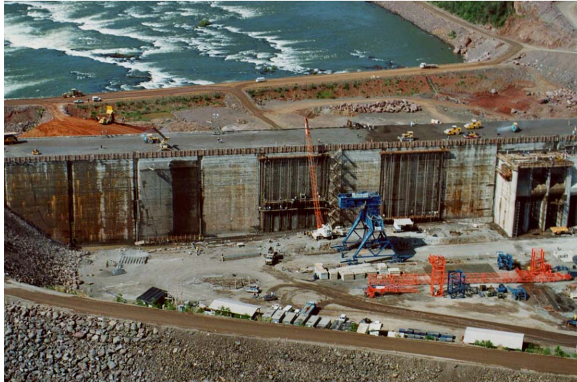
FIGURA 2.28 Visão Geral de Barragem de CCR em Construção – A Montante se vê a Face de Concreto Convencional Utilizando a Técnica de Formas Deslizantes da UHE Salto Caxias
