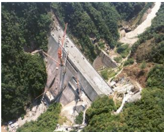
(a) durante a construção
