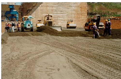
(c) Remoção após Compactação
