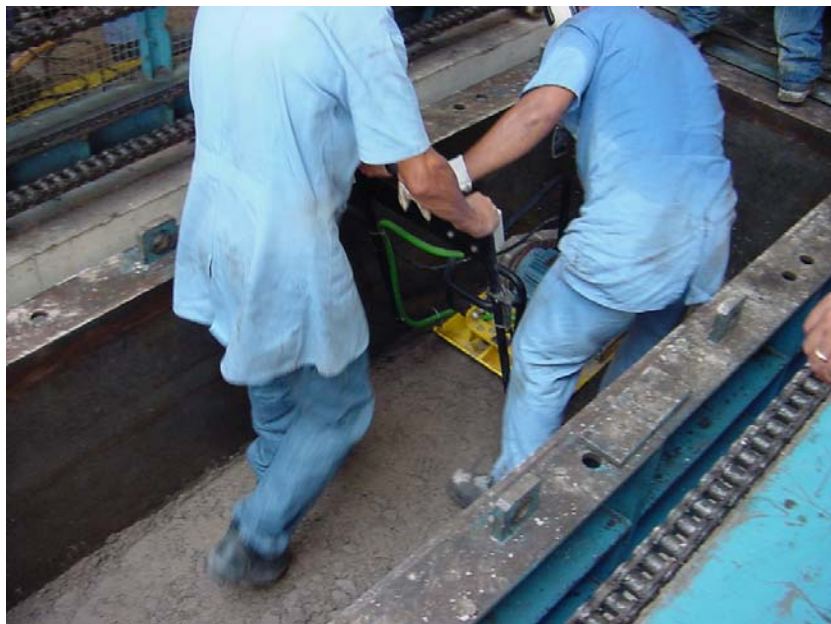
FIGURA 5.4 Regularização do Topo da Camada com Vibro-acabadora Manual
