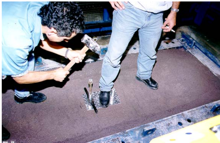
FIGURA 5.30 Execução de Furo para utilização de Densímetro Nuclear
