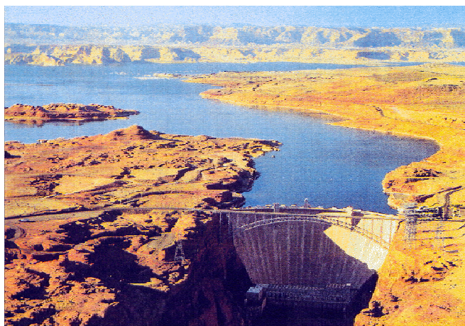
FIGURA 2.14 Vista da Barragem de Glen Canyon Rio Colorado, Arizona, EUA
