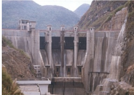
FIGURA 2.43 Vista de jusante da Barragem de Puding, China.
