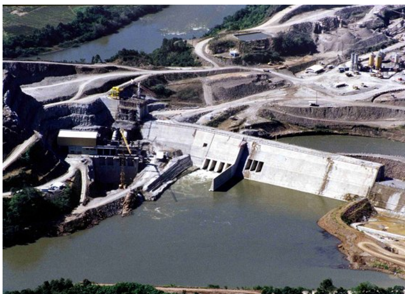
FIGURA 2.6 Vista Geral de Jusante da Barragem de Dona Francisca durante a Construção
