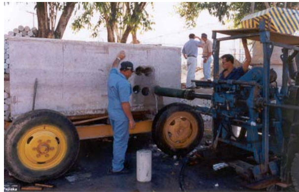
FIGURA 3.7 Obtenção de Testemunhos Horizontais nas Juntas entre Camadas de Concretagem
