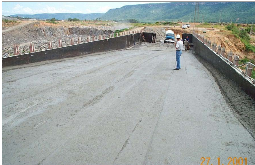
FIGURA 2.46 Aplicação do CCR Rampado na UHE Lajeado
