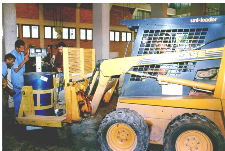
FIGURA 5.22 Pesagem dos Materiais e Abastecimento da Betoneira de 1,5 m 3
