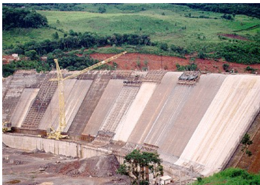
FIGURA 2.37 Execução da Face de Jusante da Barragem da Derivação do Rio Jordão
