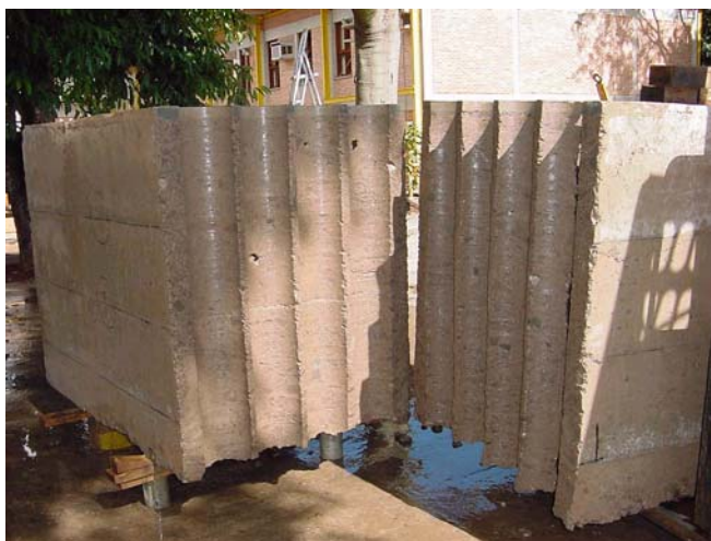
FIGURA 5.39 Vista da seção transversal
