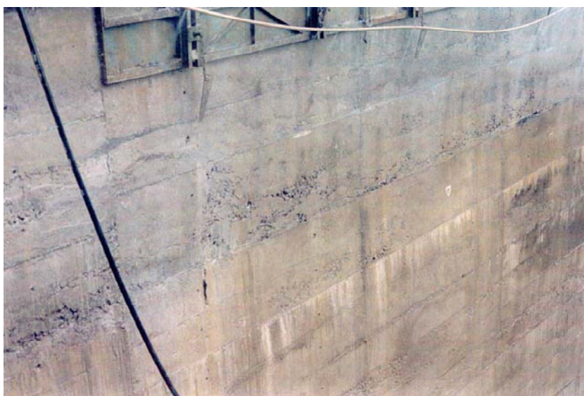
FIGURA 2.34 Face de Montante com Processo da “Árvore de Natal” da Barragem da Derivação do Rio Jordão
