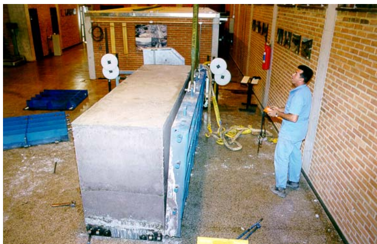
FIGURA 5.33 Continuação da Desforma com Auxílio da Ponte Rolante
