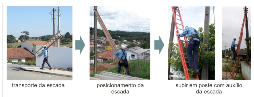
Figura 23: Procedimentos para transportar, posicionar e instalar escada
