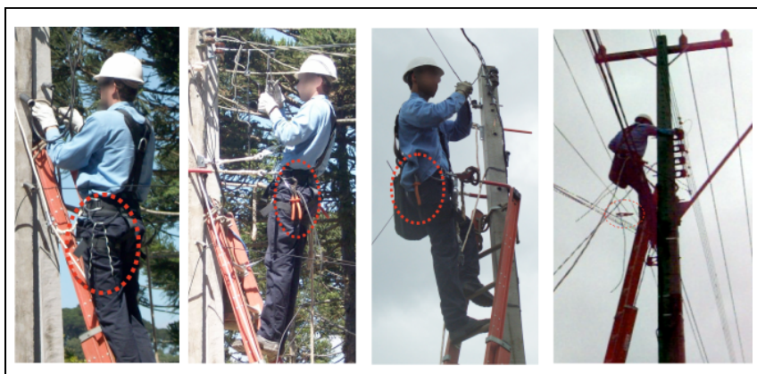
Figura 44: Eletricistas apoiam ferramentas no suporte lateral do cinturão abdominal
