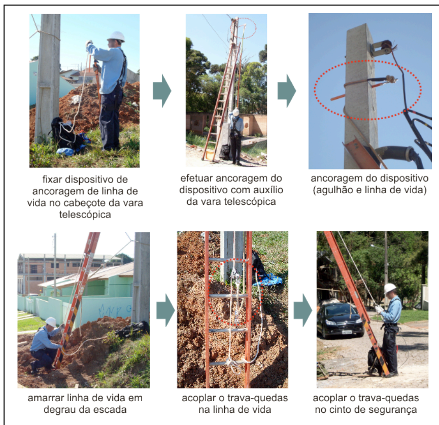
Figura 24: Procedimento de instalação do conjunto de segurança para trabalhos em altura
