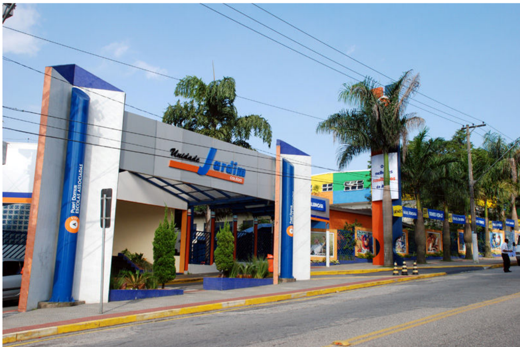
Figura 2 – Fachada da escola
