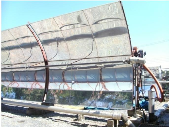
Figura 20 - Concentradores Parabólicos da usina termoeletrica solar de Minas Gerais
