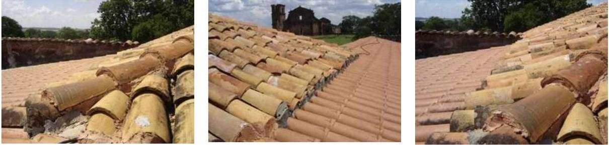
Figura 41. Várias imagens da junção do muro de pedras com telhado do alpendre do museu e das junções do telhado do museu com o telhado da casa do zelador. Vê-se que o telhado da casa foi refeito recentemente. Mas o detalhe é de uma água contínua da tacaniça de uma das faces do museu.
