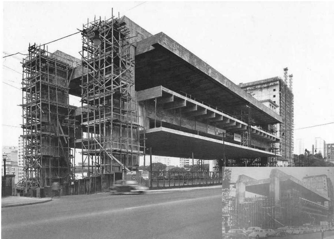
Figura 26. O MASP em obras. Sem os caixilhos, vê-se perfeitamente a dupla principal de vigas, no interior do prédio.
