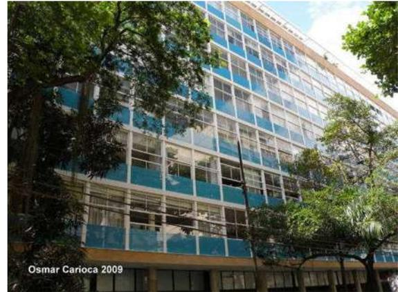
Figura 24. Idem, mas note-se a ausência do montante intermediário – que faz falta – no vidro azul do peitoril: com os vidros mais resistentes e coloridos na própria *massa*, só disponíveis anos mais tarde.
