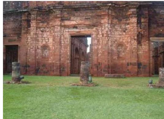
Figura 16 Fachada da Igreja sem visão do *pórtico*. Note-se o porticado da nave lateral esquerda em desaprumo.
