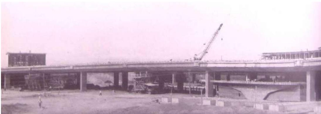
Figura 10. Construção da Plataforma Rodoviária de Brasília. À direita vê-se o pilar “T” dos mezaninos ainda escorado, em fase de concretagem.
