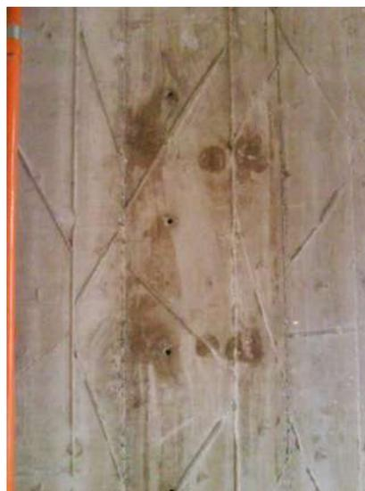
Figura 42. Idem. Nota-se as marcas dos nós das tábuas de forma.
