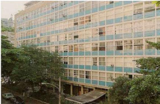
Figura 53. Fachada do Edifício Nova Cintra, com os peitoris das janelas em azul *shocking*, enquanto o original era o azul *pálido* da *paleta* característica de Lucio. Se comparada com a imagem 20, desse capítulo, vê-se também a retirada do montante intermediário de sustentação de cada um dos requadros desse peitoril. Vidros temperados – esses, coloridos na massa – são mais resistentes, dispensando a sub-divisão *com a melhor das intenções e enorme dispêndio*.
