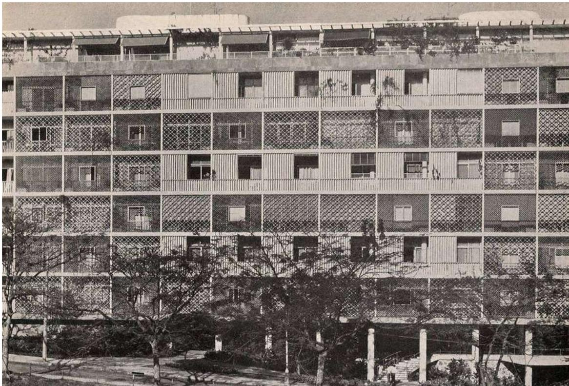
Figura 53. Foto **histórica** do livro de Henrique Mindlin: o pergolado do coroaento do ático tem a viga de borda a prumo com o plano da fachada.
