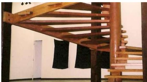
Figura 16. O sistema concebido preserva a integridade do pilar central, através do tarugo espaçador. Ao mesmo tempo os próprios degraus travam o pilar na estrutura pré-existente, através das vigas inclinadas das bordas.
