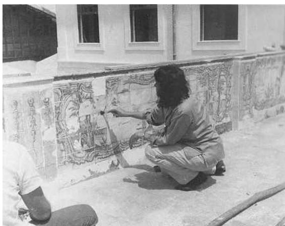
Figura 32. Lina demonstra aos operários os procedimentos na recuperação dos azulejos na ponte de acesso ao Solar.
