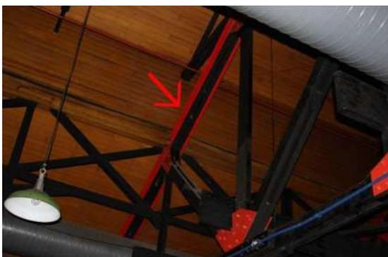
Figura 17. Tesoura do Teatro SESC Pompéia: a seta indica a intervenção de Lina, pintadas de vermelho, nas barras comprimidas; o reforço dos nós, também vermelhos, é recente.
