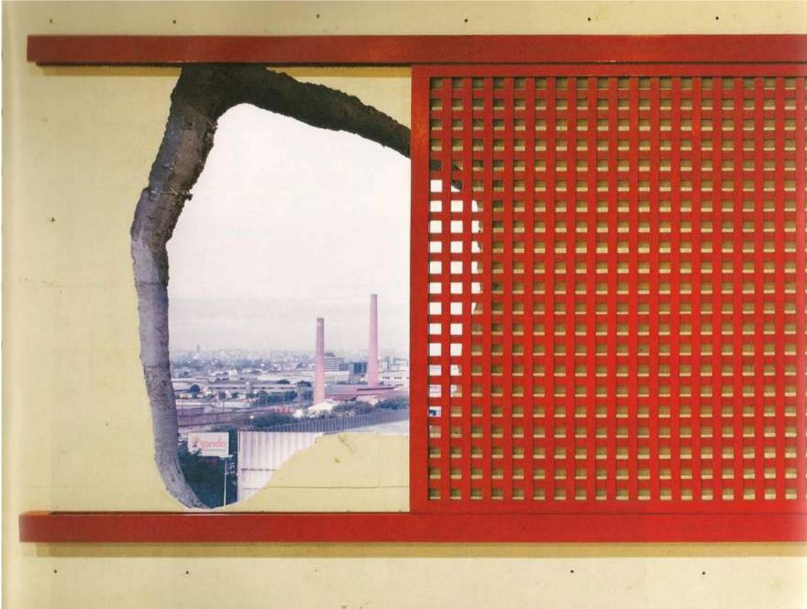
Figura 48. *Buraco* com o painel móvel de treliça, sobreposto à face interna, e não requadrando o vão.
