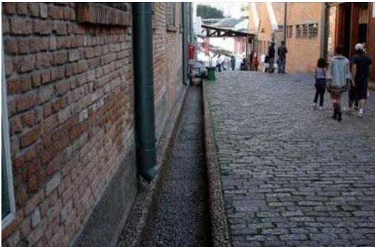
Figura 37. Canaletas de água pluvial SESC Pompéia.
