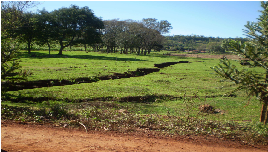
Figura 36. Processo erosivo, Bela Vista
