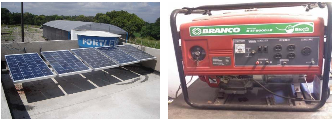
Figura 28 - Alguns dos equipamentos utilizados em aplicações de sistema híbridos junto ao Laboratório de Energias Alternativas da UFC.
