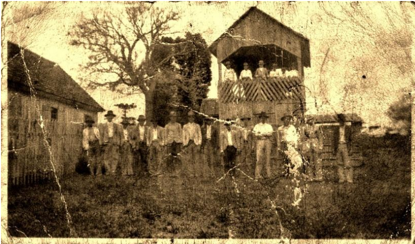
Figura 6 – Imagem possivelmente da década de 1920, mostra a capela ainda situada ao lado do cemitério. No local hoje existe apenas uma construção de madeira reservada a “Festa de Finados”. Fonte: WOEHL, Martim Cesar. Comunidade Santa Cruz . s.d. P&B., 11cm x 6cm
