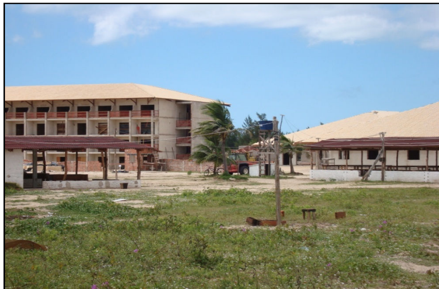
FIGURA 42 - Vila Galé Cumbuco Golf Resort – em construção. Fonte: Lúcia Sabóia, Jul./ 2009
