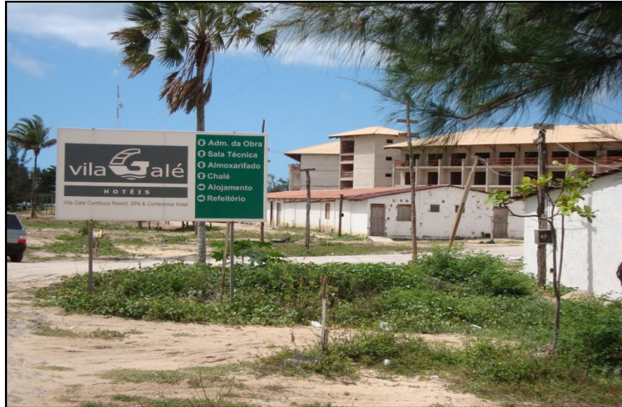
FIGURA 41 - Vila Galé Cumbuco Golf Resort – em construção. Fonte: Lúcia Sabóia, Jul./ 2009
