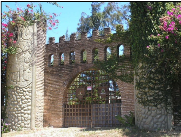
FIGURA 34 - Vista frontal de empreendimento na praia do Cumbuco.
