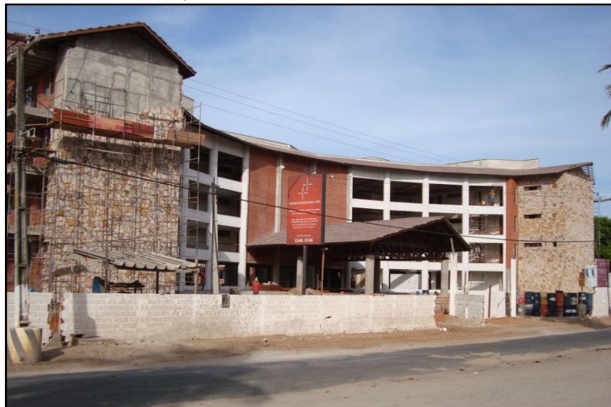
FIGURA 37 - Prédio com quatro pavimentos – em construção. Fonte: Lúcia Sabóia, Nov./ 2008
