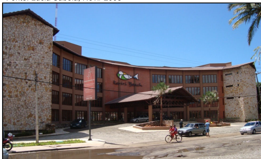
FIGURA 38 - Prédio com quatro pavimentos – construção concluída. Fonte: Lúcia Sabóia, Jul./ 2009
