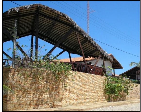
FIGURA 50 - Detalhe da cobertura de palhas. Fonte: Lúcia Sabóia, Maio/ 2008
