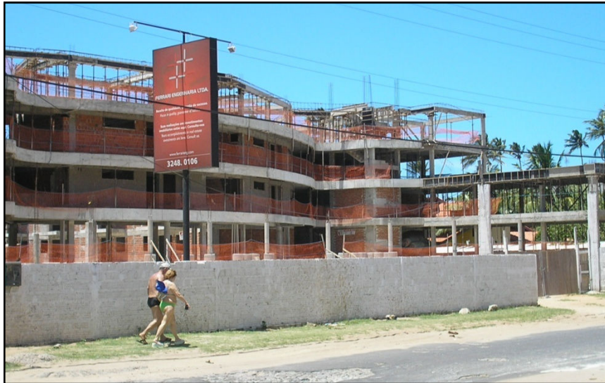
FIGURA 36 - Prédio com quatro pavimentos – início da construção. Fonte: Lúcia Sabóia, Set./ 2007
