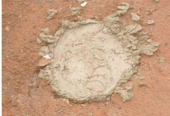
Figura 27 – Conclusão da concretagem de uma mini-estaca.
