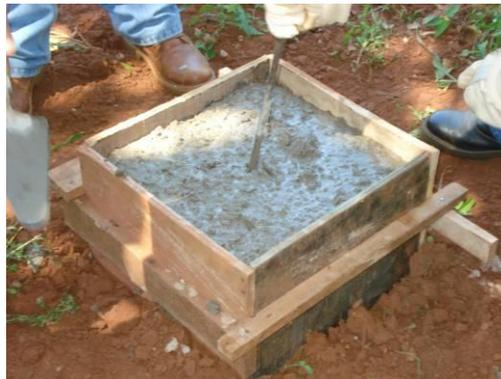
Figura 36 – Concretagem de um dos blocos.
