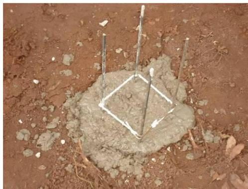
Figura 34 – Estaca pronta com os ferros de espera.
