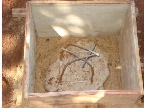
Figura 35 – Fôrma do bloco antes da concretagem.
