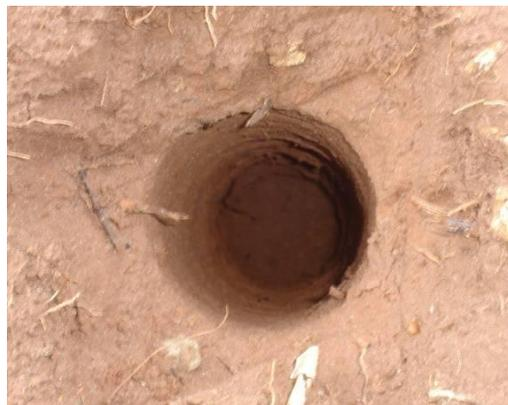
Figura 26 – Furo da mini-estaca realizado com trado manual de 10 cm.
