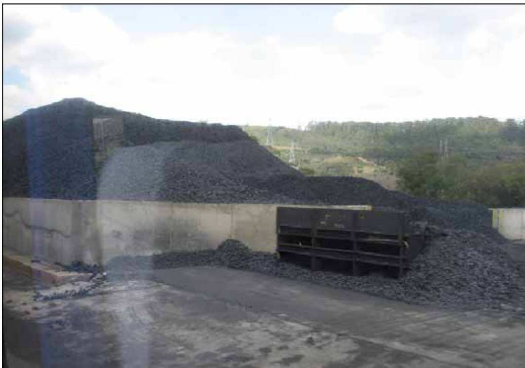
Figura 6.6. Depósito de pasta anódica a céu aberto localizado na Sala Pasta da CBA
