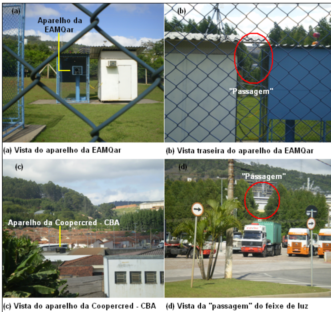
Figura 6.7. Vista geral dos aparelhos instalados na EAMQar e Coopercred - CBA
