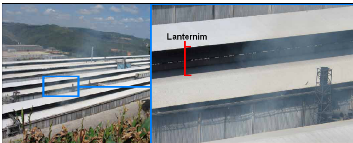
Figura 6.2. Ampliação do Lanternim de uma das Salas Fornos da CBA
