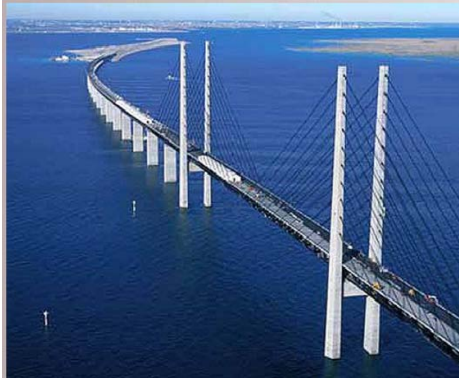
Figura 7: Great Belt Bridge entre Suécia e Dinamarca
