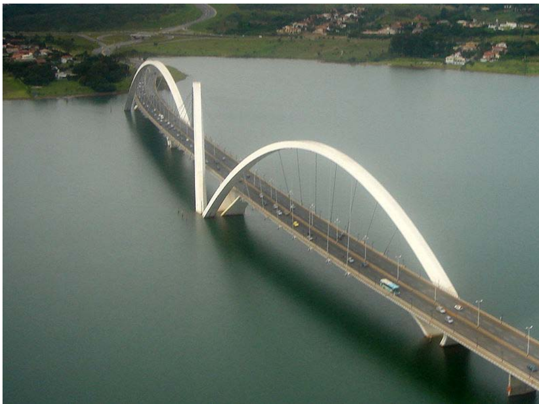
Figura 12: Ponte JK, Brasília 152
