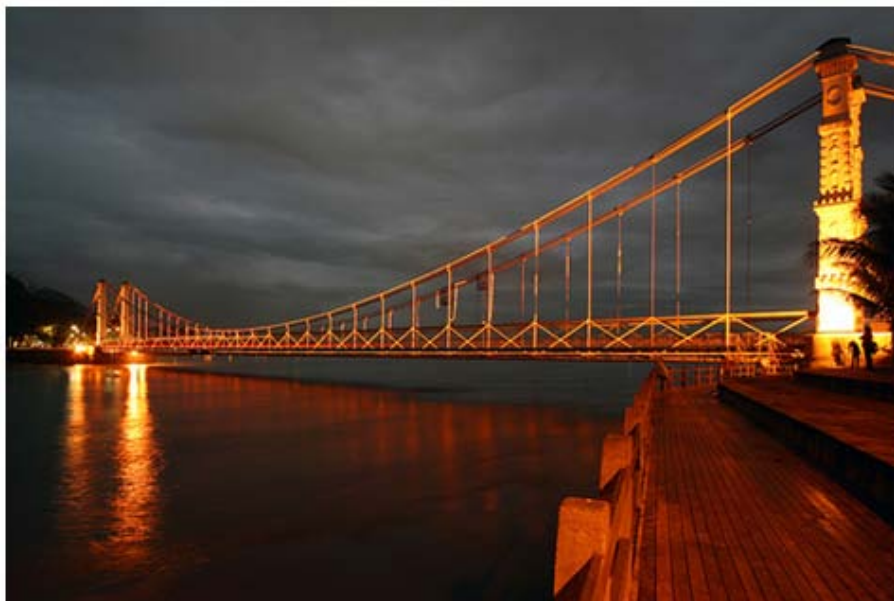
Figura 5: Ponte Pênsil de São Vicente / SP 150
