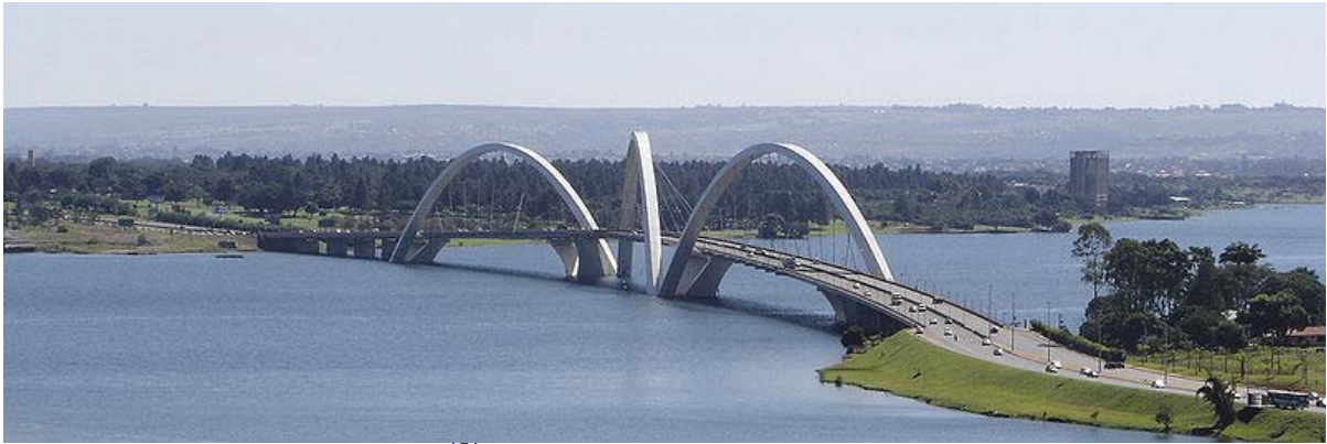
Figura 11: Ponte JK, Brasília 151
