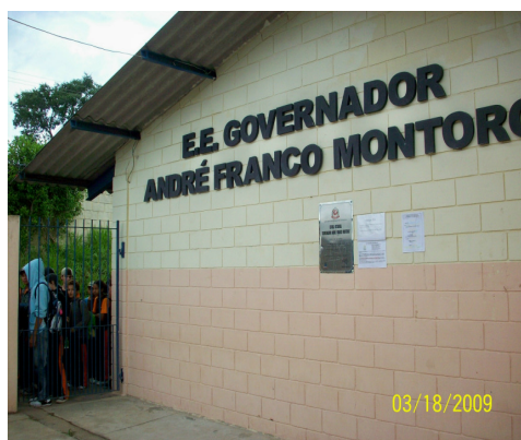
Figura 27 - Fachada da E.E. Governador André Franco Montoro
