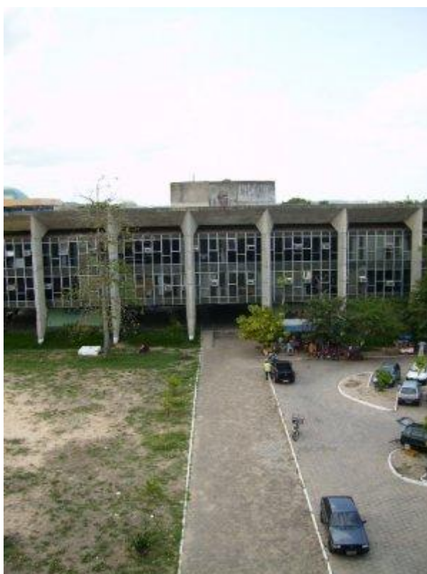
Figura 1 – Sede da Secretaria de Administração do Estado do Piauí.
