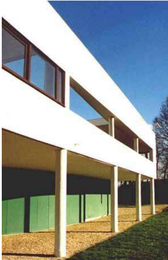
Imagem 104: Vista parcial da fachada sul, pilotis e bloco térreo recuado FONTE: MACIEL, maio 2002
