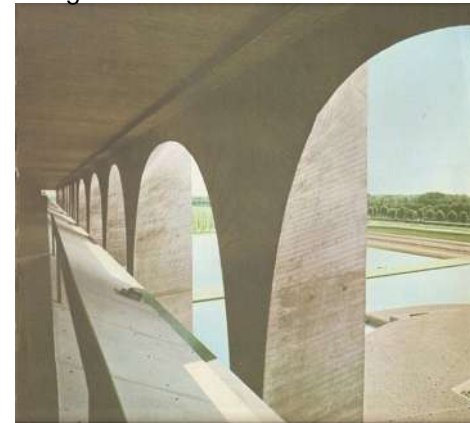
Imagem 136c: Detalhe da arcada
