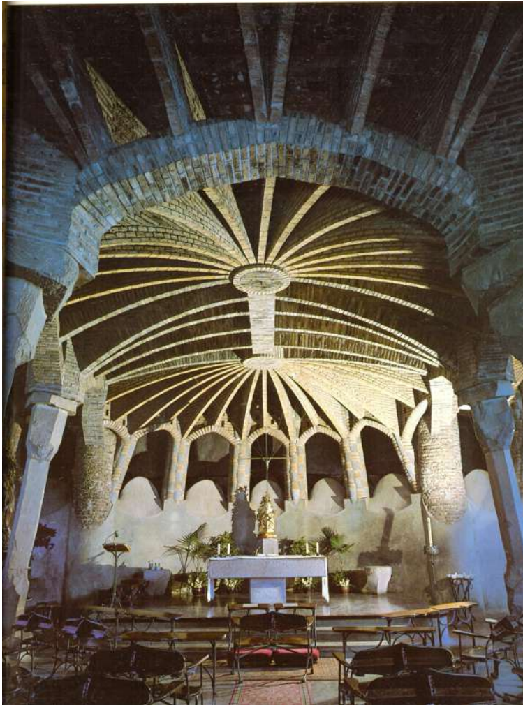
Imagem 83: Centro da cripta, cujo teto é sustentado pelas colunas de tijolos e basalto. FONTE: ZERBST, 1993
