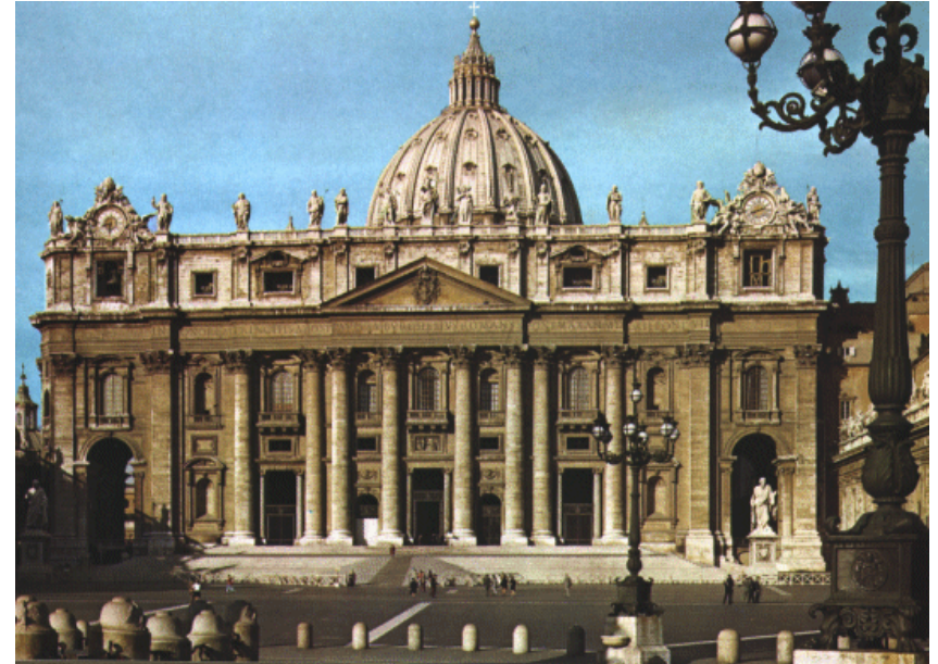
Imagem 12: Basílica de São Pedro, em Roma, de Michelangelo (século XVI) FONTE: ww.lmc.ep.usp.br/people/hlinde/Estruturas/images/Historia%20-%20renascimento_saopedro/pg04.gif , acesso em 06/06/2009
