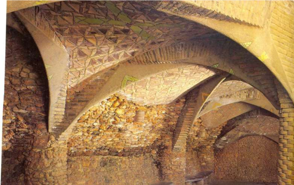
Imagem 81: Lado do pórtico, sustentado pelos arcos parabólicos. FONTE: ZERBST, 1993
