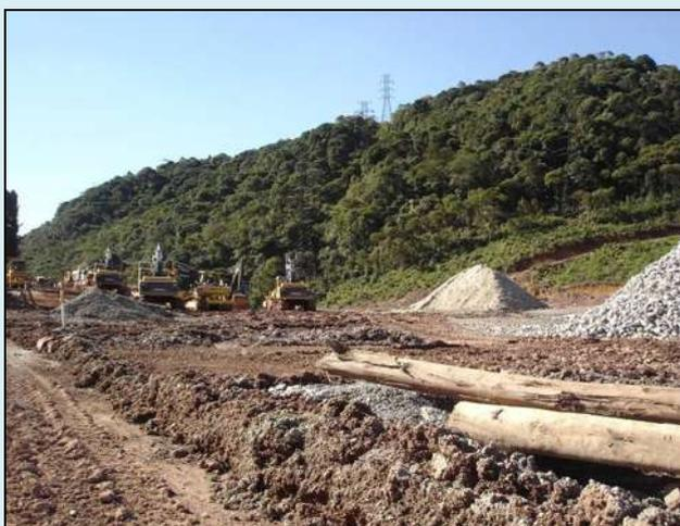
**Figura 2.13: Remoção da cobertura vegetal para a passagem da faixa de domínio do Trecho Sul do Rodoanel.**
