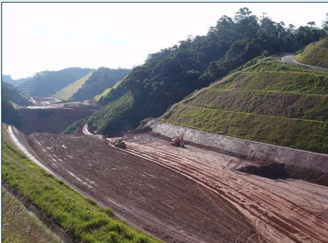
**Figura 2.6: Abertura da faixa de rolamento do lote 2 do Trecho Sul do Rodoanel, SBC.**
