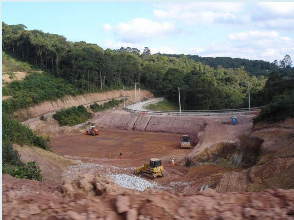
**Figura 5.36: Movimentação de terra no Depósito de Material Excedente (DME), próximo da estrada Ângelo Demarchi**
