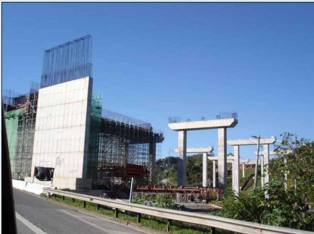
**Figura 2.8: Armação dos pilares do Trecho Sul para transpor a Rodovia Anchieta em SBC. Vista sentido Mauá.**
