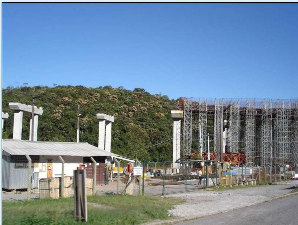
**Figura 2.9: Armação dos pilares do Trecho Sul para transpor a Rodovia Anchieta em SBC. Vista sentido represa Billings.**
