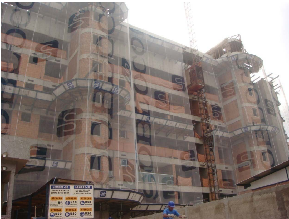
Figura 38 – Edifício Majestic em obras. Foto: Ana Paula Alípio, 2008.
