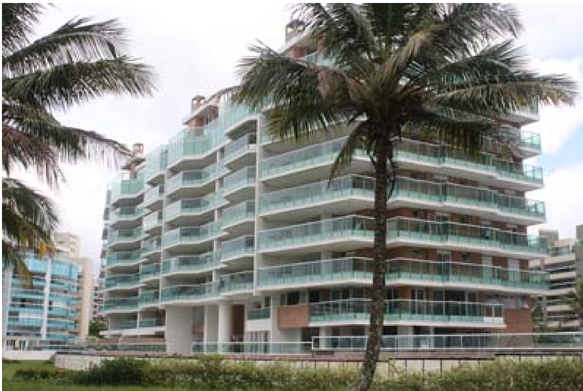
Figura 40 – Fachada do Edifício Majestic. Foto: Ana Paula Alípio, 2009.
