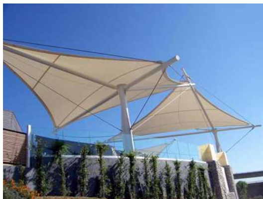
Figura A37 Tendas Hiperbólicas em restaurante na Califórnia - The Minx Restaurant – Glendale, disponível em http://www.tensionstructures.com/minx.htm (04/07/2007).
