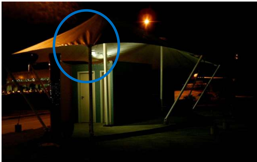
Figura 6.4 Enrugamento de membrana no encontro do topo do mastro de borda lateral direita (da autora, 2007)
