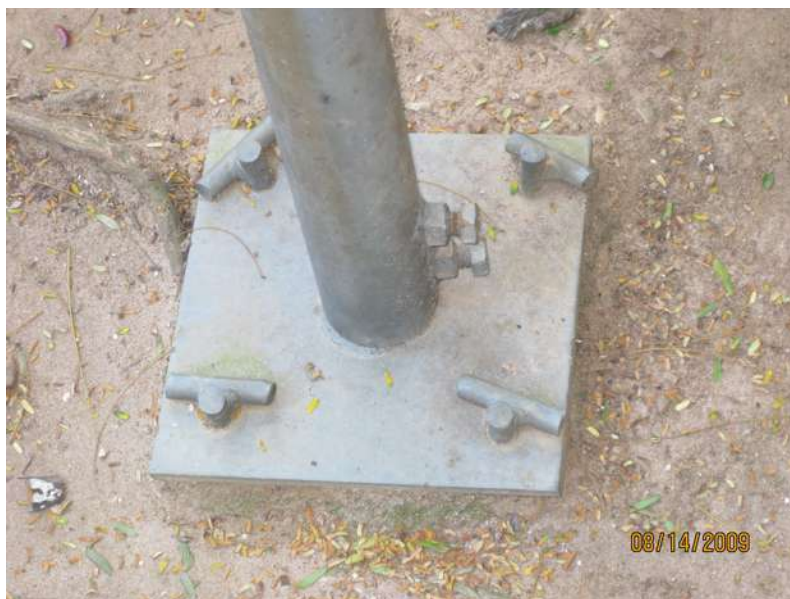
Figura 6.21 Base de mastro sobre chapa fixada com pino com cabeças soldadas (da autora, 2009)
