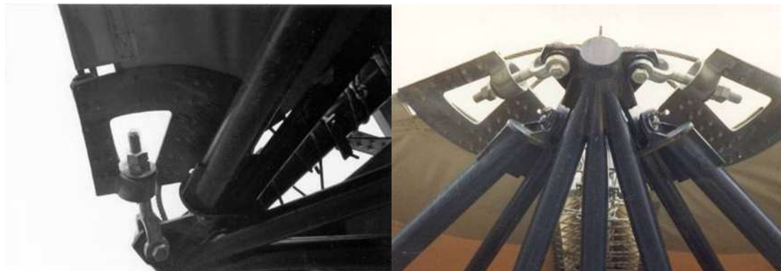
Figura 5.122 Vista inferior detalhando o grampeamento e as conexões nas terminalidades da cobertura no Aeroporto de Lyon Satolas, disponível em TENSINET(2007).
