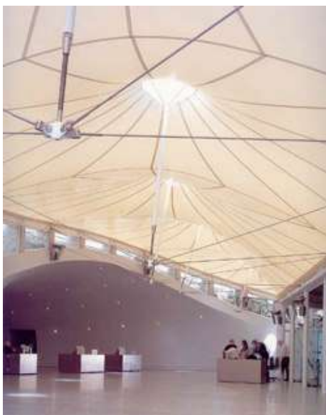
Figura A24 Cobertura do Bristol Wildscreen Atrium, projetado pelo engenheiro Gavin Sayers, tendo como sustentação o sistema em tensegrity, disponível em http://www.ddassoc.co.uk/people/gsayer.shtml# (07/07/2007).
