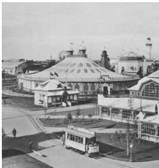
Figura A14 Pavilhão oval tensionado disponível em http://en.wikipedia.org/wiki/Image:Oval_pavilion_by_Vladimir_Shukhov_in_Nizhny_Novgorod_1896.jpg (04/07/2007).
