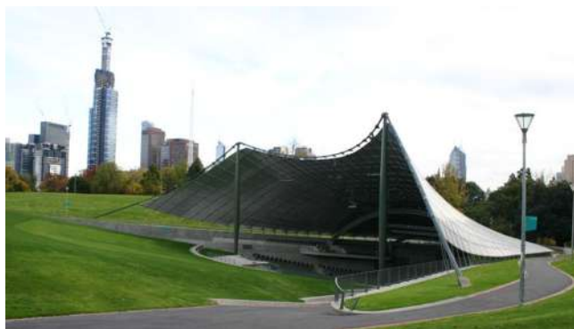
Figura A7 Auditório Sidney Myer Music Bowl em redes de cabos, disponível em http://en.wikipedia.org/wiki/Image:Sidney_Myer_Music_Bowl.jpg (04/07/2007)
