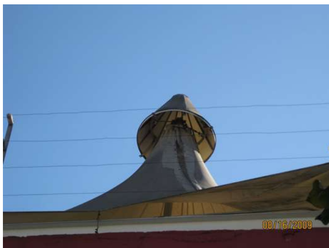
Figura 6.36 Recuperação da membrana, costura por encadernamento (da autora, 2009).
