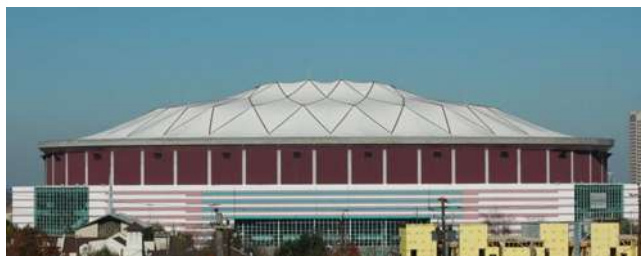
Figura A11 Cobertura do Georgia Dome em têxtil estrutural ,PTFE, e estrutura de apoio em tensegrity, disponível em http://en.wikipedia.org/wiki/Image:GeorgiaDome_md.jpg (04/07/2007).
