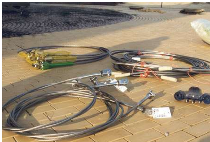
Figura 5.198 Romaneio de cabos com terminações durante início de montagem de espaço Público de uso temporário na Bélgica, disponível em http://www.tensinet.com/database/viewProject/3995.html 17/07/2009
