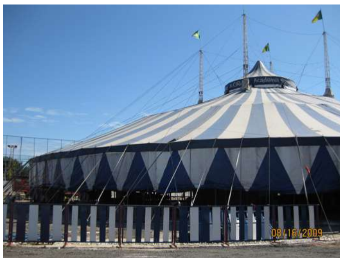
Figura 6.42 Vista da composição da cobertura com saia de fechamento vertical semi-aberta (da autora, 2009)
