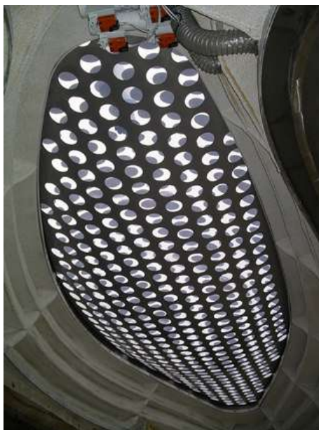
Figura 5.10 Filmes impressos de ETFE e controle pneumático do colchão da cobertura do Villa Nurbs (disponível em http://www.ruiz-geli.com/04_html/04_villanurbs.html , acesso em 06/07/2009)
