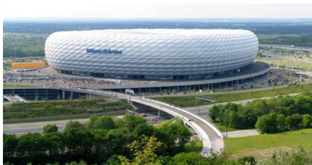
Figura A9 Cobertura e fechamento lateral do estádio Allianz Arena em ETFE, disponível em http://en.wikipedia.org/wiki/Image:Allianz_Arena_Pahu.jpg (04/07/2007).
