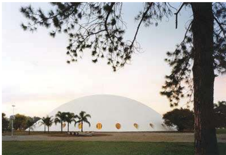
Figura 5.158 Vista da Oca no bairro do Ibirapuera em São Paulo, após a recuperação em que recebeu uma membrana branca de PVC para impermeabilização, disponível em http://www.projetodesign.com.br/arquitetura/arquitetura8.asp (04/07/2007).
