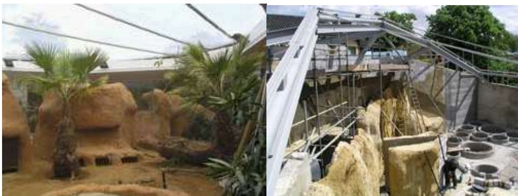
Figura A23 Jaula do Dragão de Komodo no zoológico de Londres - Zoological Society London, com membranas duplas de ETFE suportadas por estrutura metálica e cabos em um vão de 15m, projeto arquitetônico de 2004 de Wharmby Kozdon Architects e estrutura de David Dexter Associates, disponível em http://www.ddassoc.co.uk/projects/etfe/komodo.shtml (06/07/2007).
