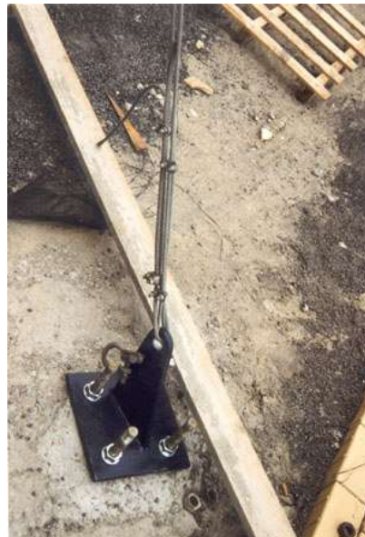
Figura 5.210 Ancoragem com cabo em olhal durante etapa construtiva de Espaço Público de uso temporário na Bélgica, disponível em http://www.tensinet.com/database/viewProject/3995.html 17/07/2009
