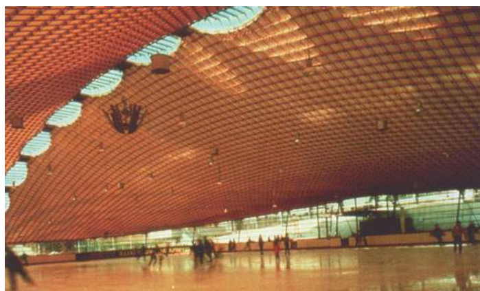
Figura 5.29 Cobertura do Munich Rink, vista interna (HUNTINGTON, 2004).
