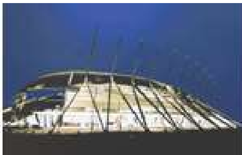
Figura 3.13 Projeto Complexo Aquático - Jogos Panamericanos do aluno Guilherme Canhisares Amadeu, menção honrosa no concurso Ópera Prima – projetando com PVC – 2004, sob orientação da autora, disponível em http://www.projetandocompvc.com.br/opera_prima/anterior/vencedores.asp .
