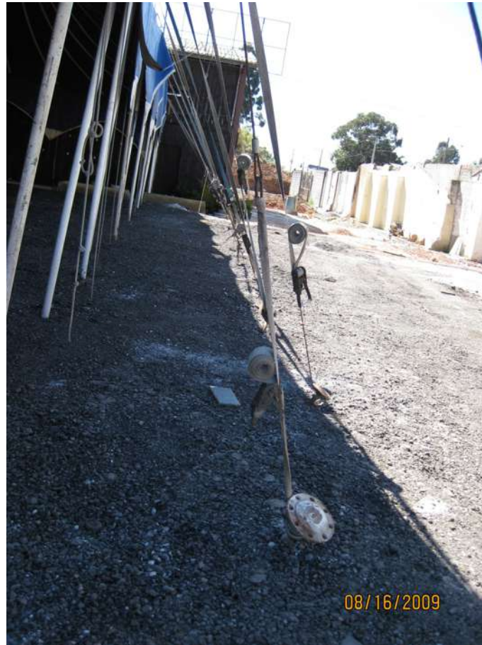
Figura 6.45 Vista lateral da tenda, destacando as estacas e as cintas de tensionamento (da autora, 2009)
