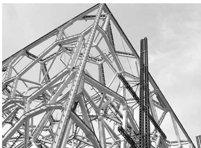
Figura 5.67 A vista em detalhe dos quadros de canto e borda superior do Cubo Aquático (PTW / China State Construction Engineering apud GONCHAR, 2008).
