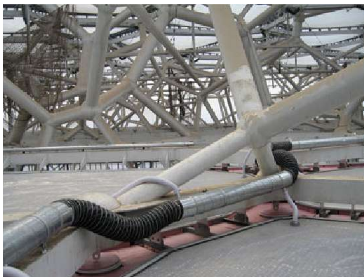
Figura 5.58 Conexões metálicas de fixação dos colchões de ETFE e as tubulações para inflar ( disponível em http://www.natgeo.com.br/especiais/estadionacionaldepequim/gallery.asp 04/08/2008)
