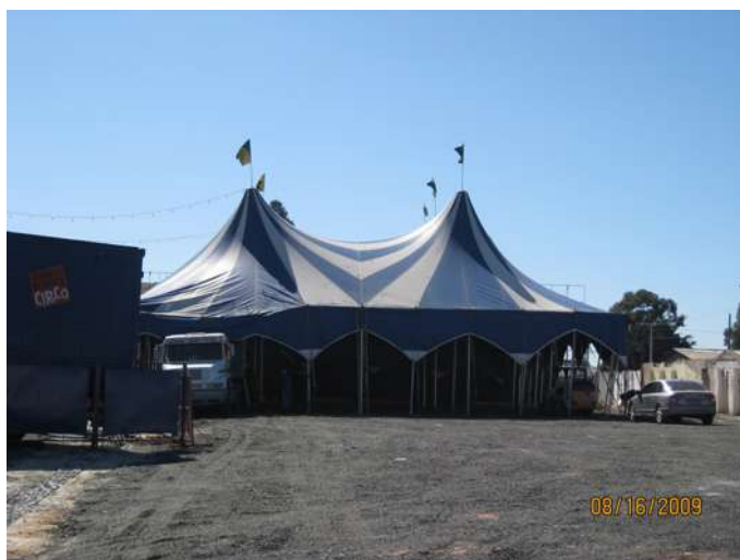
Figura 6.44 Perda de tracionamento da membrana por destacamento de apoios (da autora, 2009).
