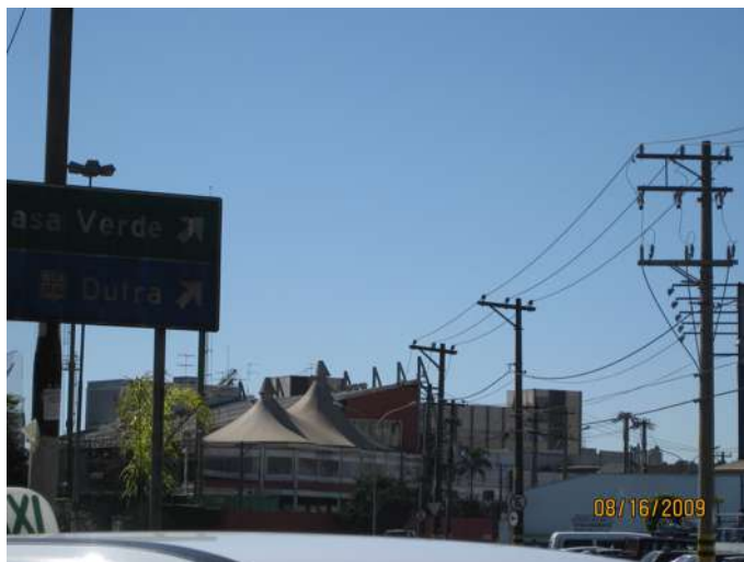
Figura 6.30 Vista geral da obra e parte de seu entorno (da autora, 2009).
