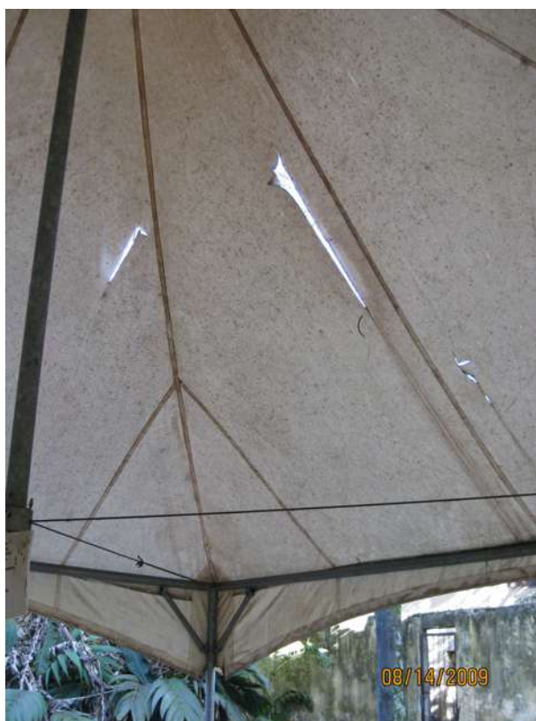
Figura 6.24 Vista dos cabos passantes no pé do mastro flutuante e chegada ao nó estrutural de canto (da autora, 2009)
