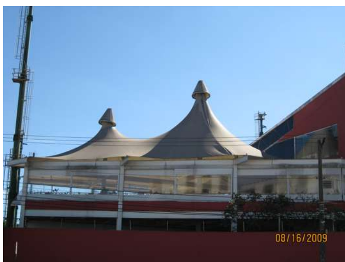
Figura 6.32 Posicionamento dos cones de fechamento de pico e alinhamento de rasgo na membrana (da autora, 2009)
