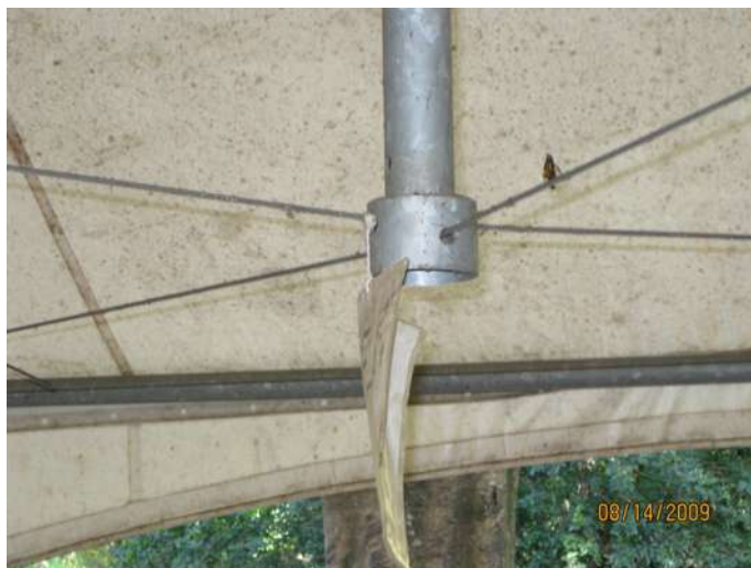
Figura 6.25 Vista geral da base em forma de copo do mastro flutuante (da autora, 2009)
