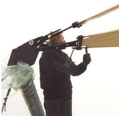
Figura 5.205 Término selado de cabo facilitando a fixação de ferramenta na montagem em espaço de uso temporário na Bélgica, disponível em http://www.tensinet.com/database/viewProject/3995.html 17/07/2009
