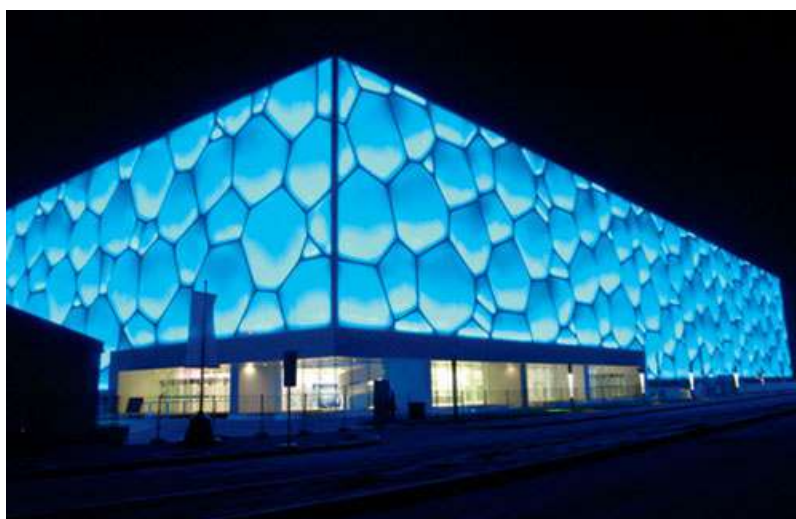
Figura 5.63 O sistema em parede dupla de ETFE no Cubo Aquático no período noturno, efeito de uma caixa azul brilhante pela instalação de LEDs (PTW apud GONCHAR, 2008).
