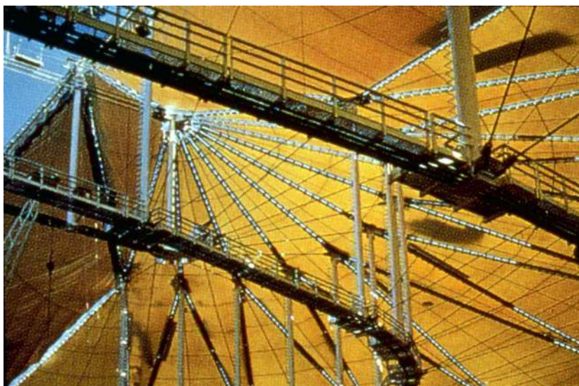
Figura 5.110 Instalação de painel de membrana em PTFE na cobertura do Georgia Dome em Atlanta (Disponível em http://www.columbia.edu/cu/gsap/BT/DOMES/GEORGIA/ em 08/08/2001).
