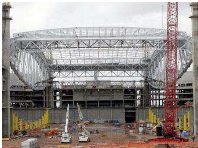
Figura 5.98 Fase construtiva nota-se as treliças de apoio da cobertura retrátil e as torres de apoio. (Arizona Cardinals, 2007. Disponível em http://www.azcentral.com/sports/cardinals/ em 26/03/2007).
