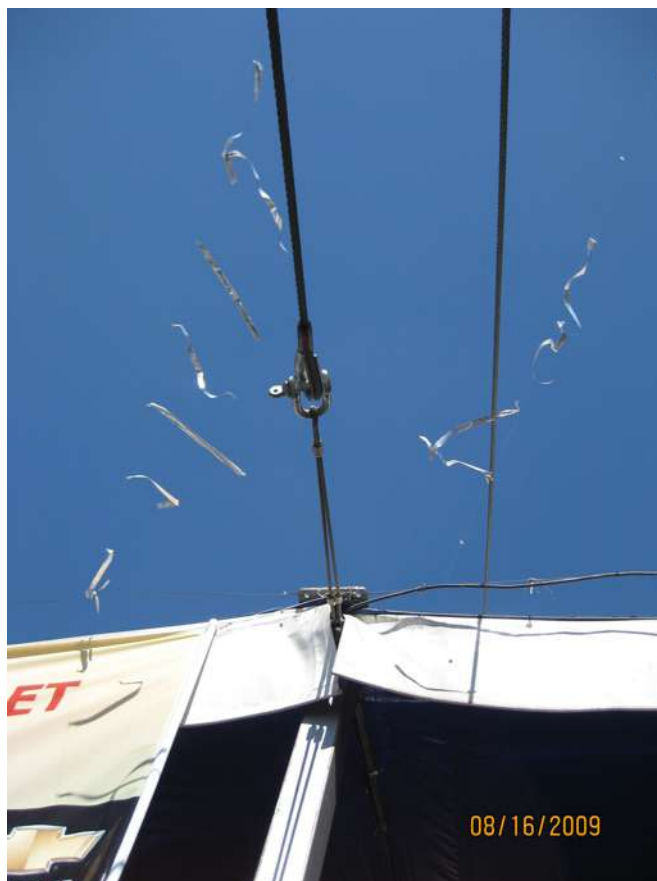
Figura 6.69 Vista da saia interrompida para passagem de ancoragem e conexões (da autora, 2009).
