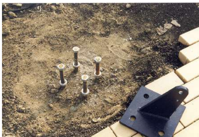
Figura 5.212 Ancoragem com parafuso durante etapa construtiva de Espaço Público de uso temporário na Bélgica, disponível em http://www.tensinet.com/database/viewProject/3995.html 17/07/2009
