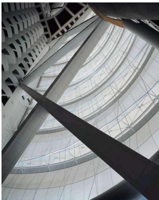
Figura 1.27 Vista interna da vedação vertical do Burj al Arab Hotel em Dubai no Emirados Árabes, construído em 1999, disponível em TENSINET (2007).
