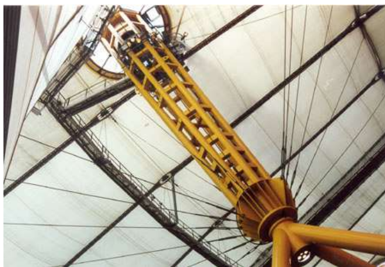
Figura 5.235 Anel tensor no Millennium Dome em Londres, disponível em http://www.tensinet.com/database/viewProject/3782.html em 17/07/2009.
