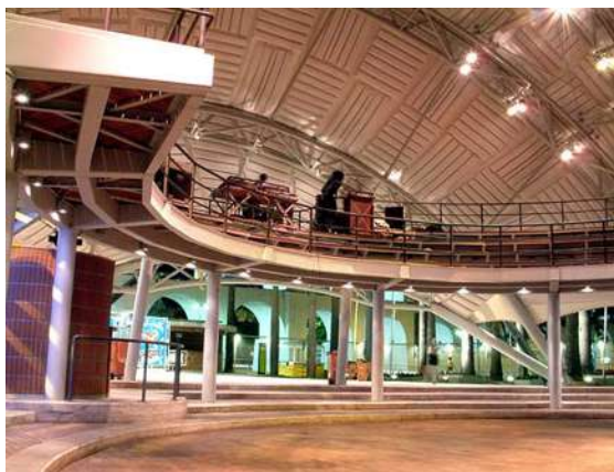
Figura 5.41 Vista dos colchões acústicos de PVC instalados no Circo Voador (disponível em 13/08/2008 no site http://www.metallica.com.br/pg_dinamica/bin/pg_dinamica.php?id_pag=1312 ).
