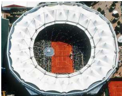
Figura 5.78 Vista superior do Estádio Rothenbaun em Hamburgo na posição da membrana aberta - Rothenbaum Tennis Court. (disponibilizado por SPACE MODULAR em http://space-modulator.jp/sm81~90/sm90_contents/sm90_e_curv02.html em 06/07/2007).
