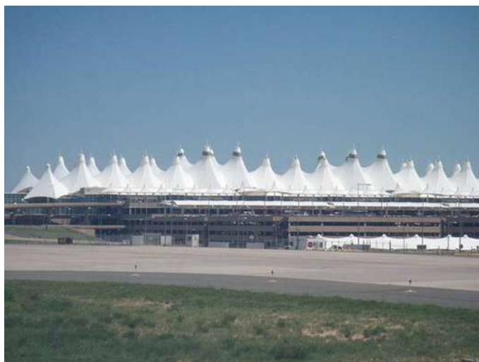
Figura 5.138 Aeroporto Internacional de Denver tendo a cobertura a forma inspirada nas Montanhas Rochosas, em têxtil estrutural PTFE, disponível em http://en.wikipedia.org/wiki/Image:DEN-JEP_TERMINAL.JPG (04/07/2007).
