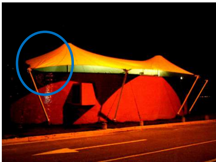
Figura 6.6: Enrugamento da membrana no topo de mastro da face posterior da obra (da autora, 2007)
