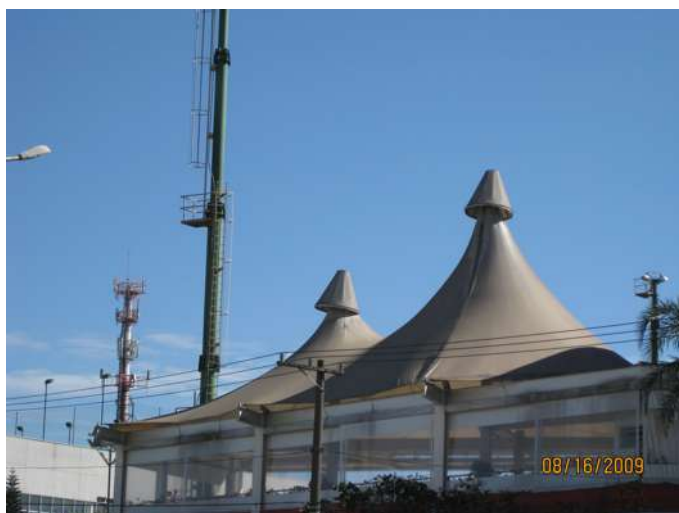
Figura 6.31 Vista geral e vista dos fechamentos da fachada (da autora, 2009).
