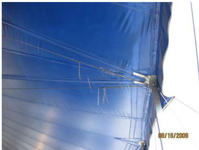
Figura 6.63 Vista das fixações alternadas dos mastros laterais (da autora, 2009).
