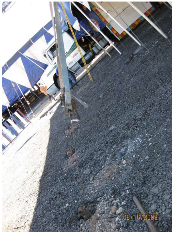
Figura 6.52 Vista geral do entorno das estacas escavado (da autora, 2009).
