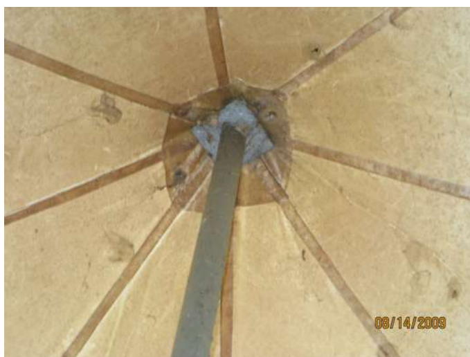
Figura 6.28 Vista interior da ligação mastro central e membrana (da autora, 2009).
