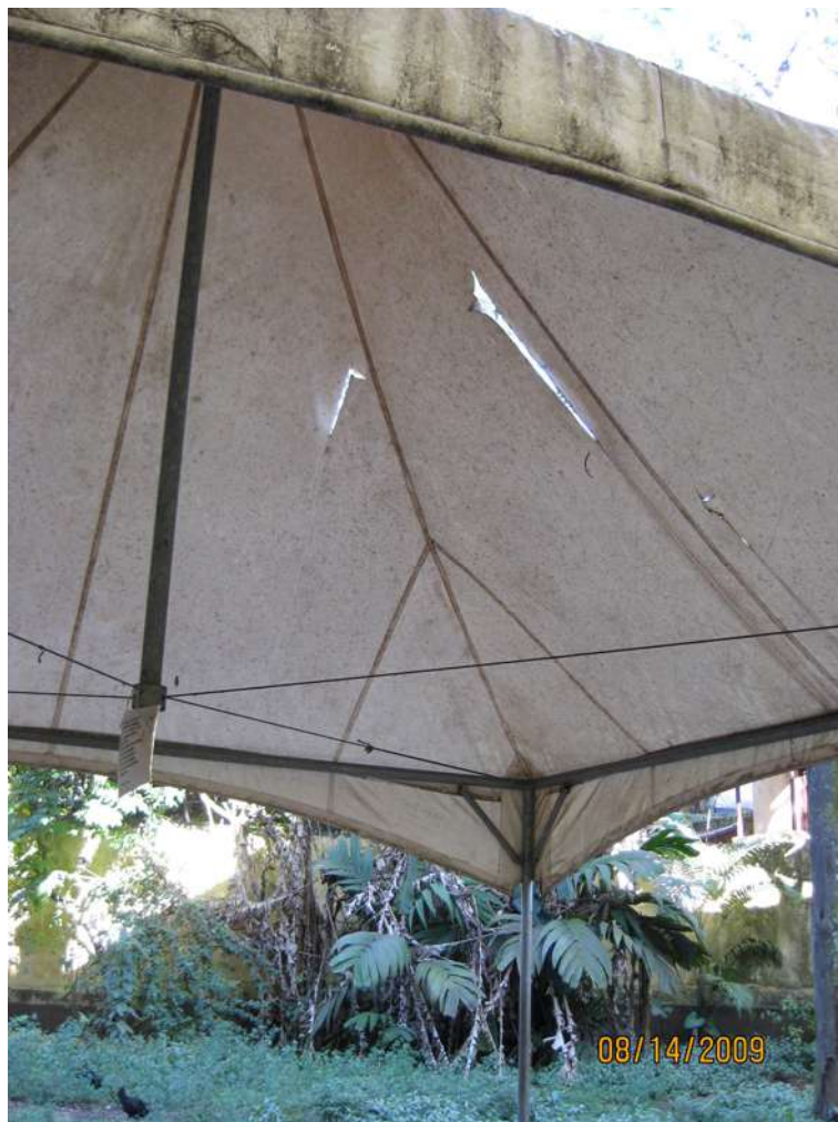
Figura 6.13 Vista interna da tenda apoiada no centro em mastro sobre cabos, destaque aos rasgos e bordas sujas (da autora, 2009).
