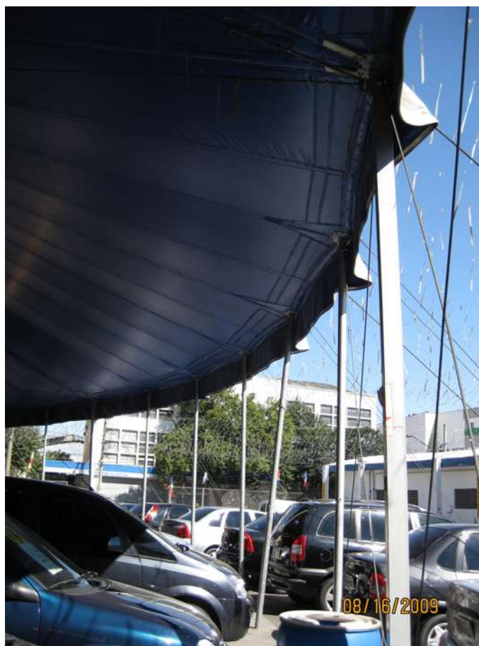
Figura 6.64 Vista de mastros de seções circulares e quadradas (da autora, 2009).
