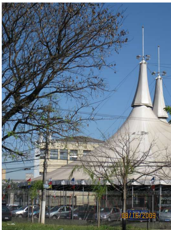
Figura 6.59 Vista de um alinhamento de costura e cones de fechamento com enrugamentos de membrana (da autora, 2009).
