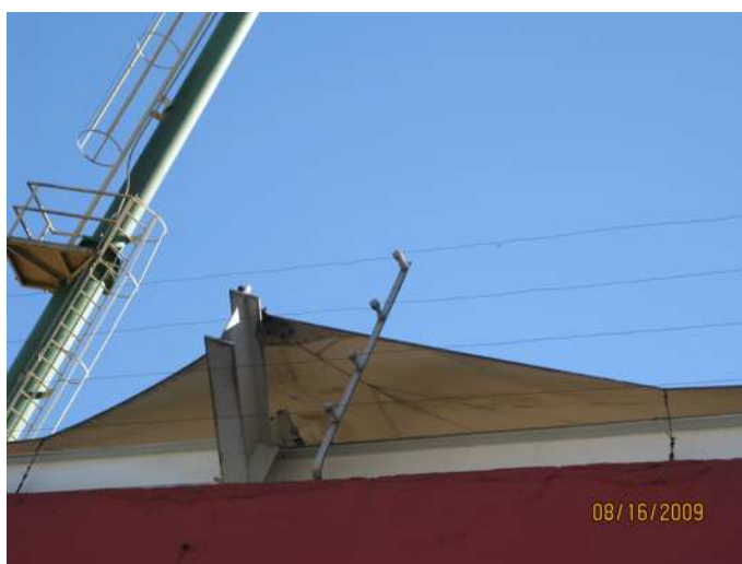
Figura 6.39 Vista da conexão de extremidades membrana-viga em face lateral da cobertura (da autora, 2009)
