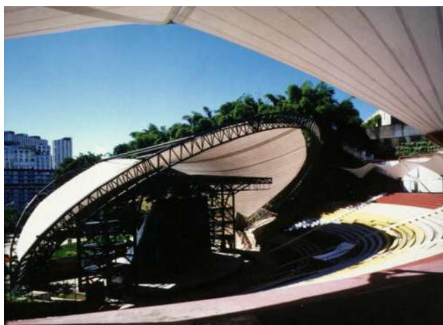
Figura A8 Teatro Castro Alves, Salvador em têtil estrutural, cob. Nelson Fiedler, disponível em OBATA e PATRÍCIO (2001).
