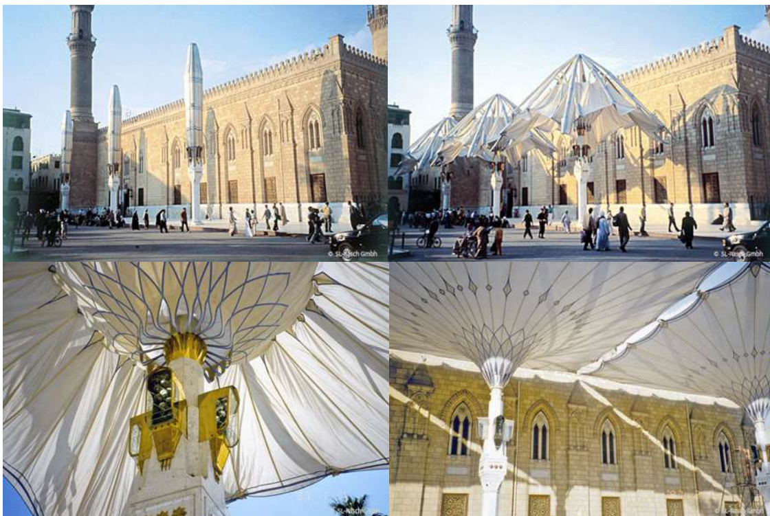
Figura 5.45 Etapas de abertura das “umbrellas” da Mesquita Al-Hussein no Cairo, Egito (disponível em http://www.sl-rasch.de/ em 15/08/2008).
