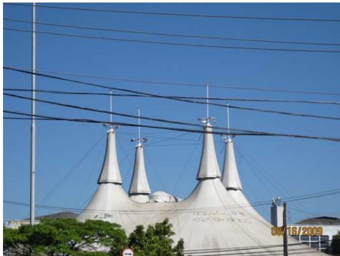
Figura 6.60 Vista geral dos cones de fechamento dos mastros (da autora, 2009).
