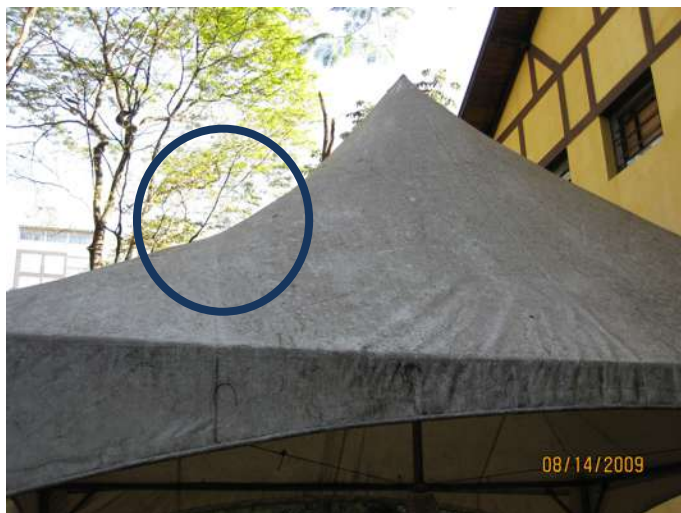
Figura 6.27 Vista do pico e descontinuidade de curvatura da membrana (da autora, 2009)
