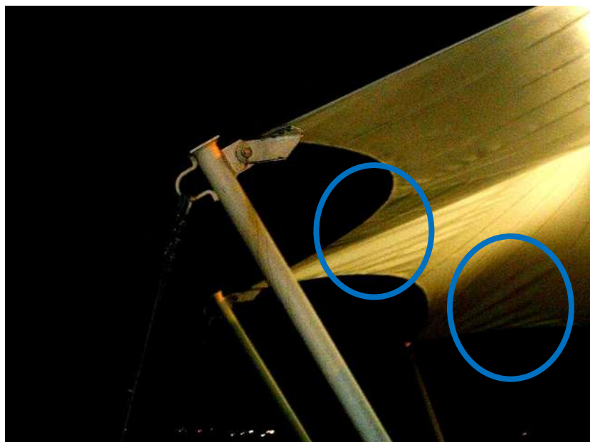
Figura 6.8 Vista geral da parte frontal da membrana com indicações da superfície enrugada da membrana (da autora, 2007)
