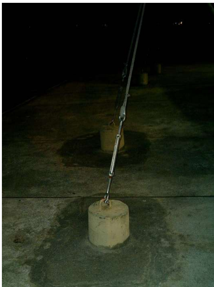
Figura 6.3 Vista dos pontos de ancoragem dos cabos no solo (da autora, 2007).
