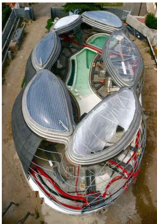
Figura 5.12 Vista superior da obra do Vila Nurbs, tendo com vista os tubos estruturais de fechamento da obra, disponível em http://www.villanurbs.com/ (acesso em 06/07/2009).
