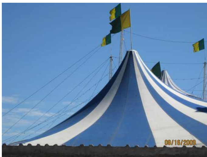
Figura 6.48 Vista de pico apoiado sobre chapa interna e sem chapar de cobertura (da autora, 2009).
