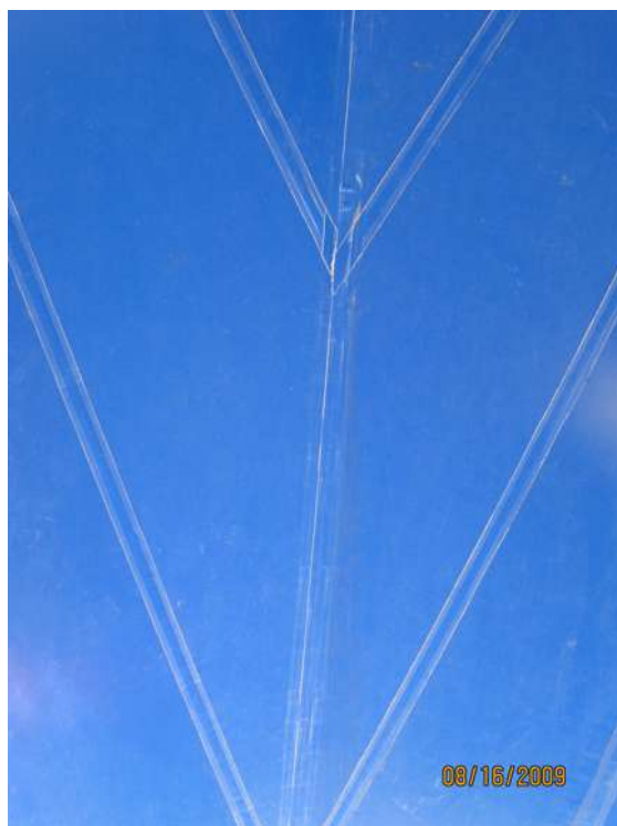
Figura 6.71 Linhas de costuras por soldagem em forma de espinha de peixe (da autora, 2009).
