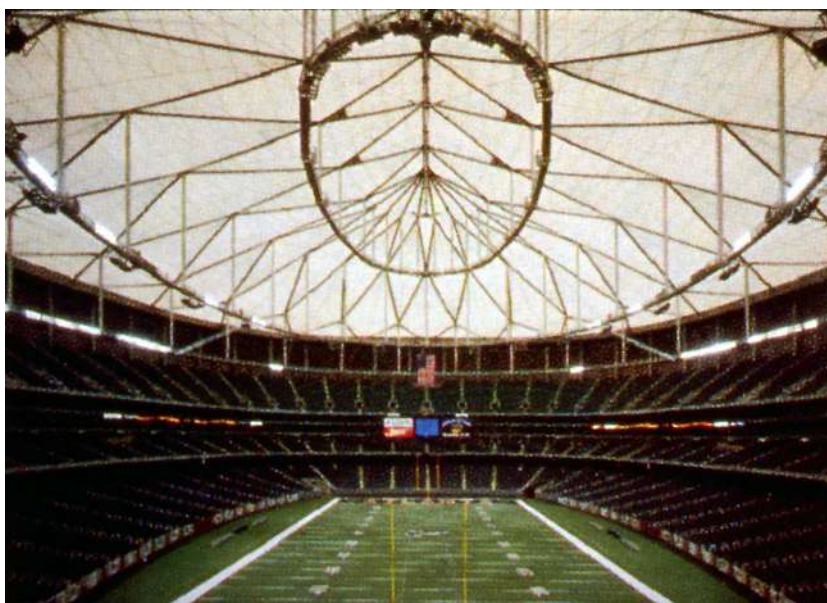
Figura 5.111 Instalação de painel de membrana em PTFE na cobertura do Georgia Dome em Atlanta (Disponível em http://www.columbia.edu/cu/gsap/BT/DOMES/GEORGIA/ em 08/08/2001).
