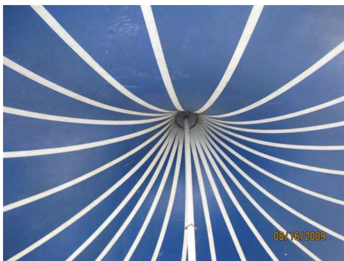
Figura 6.56 Vista interna do mastro principal com chapa de apoio e direcionamento das emendas neste ponto (da autora, 2009).
