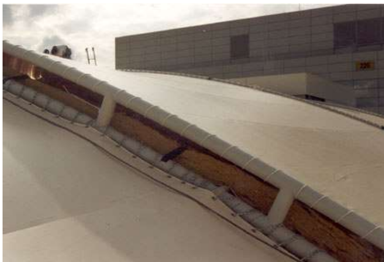
Figura 5.153 Vista da dupla membrana fixada por costura no banzo inferior e superior da viga treliçada, em fase de montagem do galpão de aeroporto em Zaventem, Brussel – Bélgica, disponível em http://www.tensinet.com/database/viewProject/3996.html em 17/07/2009.
