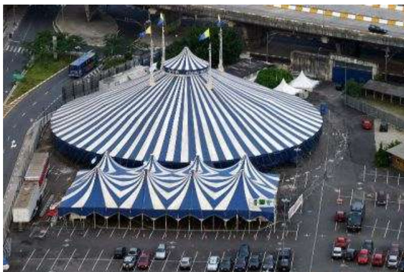
Figura 6.40 Vista geral das coberturas em membrana da Academia Brasileira de Circo. Disponível em http://www.academiadecirco.com.br/galeria_fotos.php?pagina=1&id=38 em 21/08/09.
