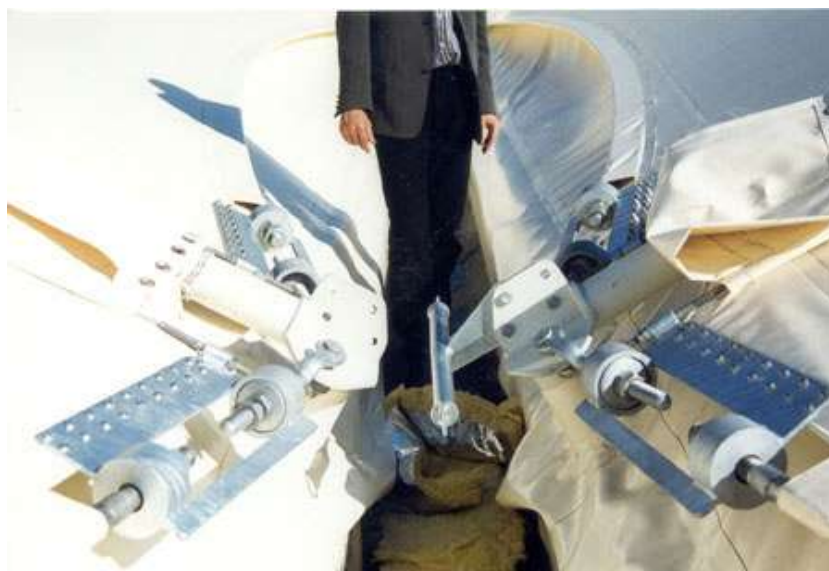
Figura 5.155 Vista das placas de isolamento térmico e membrana interna sem contato com a calha de drenagem do galpão de aeroporto em Zaventem, Brussel – Bélgica, disponível em http://www.tensinet.com/database/viewProject/3996.html em 17/07/2009.
