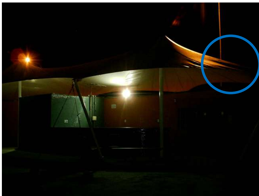
Figura 6.5: Enrugamento ao longo da borda em catenária da membrana (da autora, 2007)
