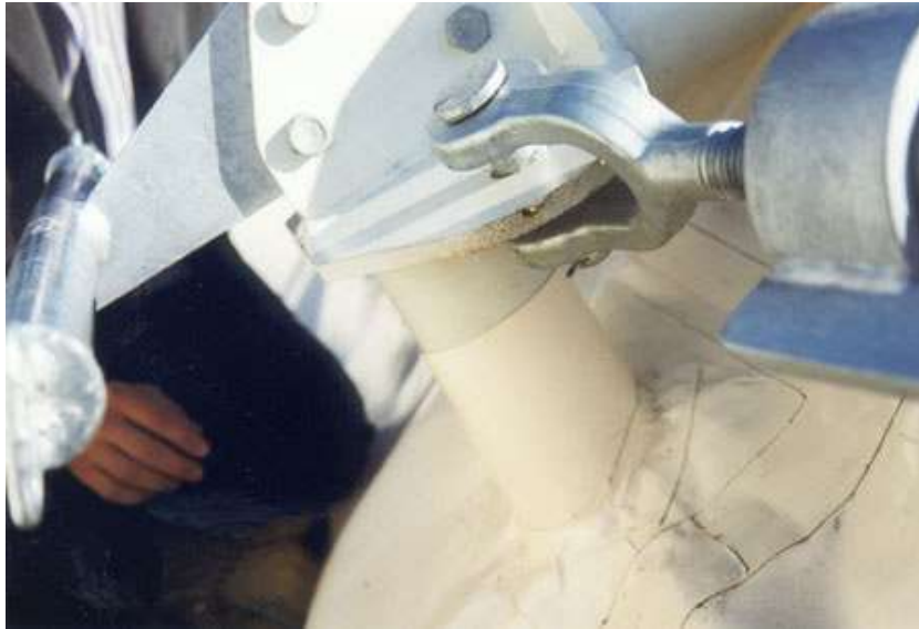
Figura 5.157 Vista da membrana externa com sobreposição em tubulação de drenagem no galpão de aeroporto em Zaventem, Brussel – Bélgica, disponível em http://www.tensinet.com/database/viewProject/3996.html em 17/07/2009.
