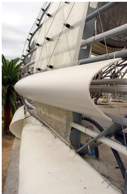
Figura 5.15 Placas Brancas de Corian sobre membrana e rede de cabos tensionados do Vila Nurbs, disponível em http://www.villanurbs.com/ (acesso em 06/07/2009).
