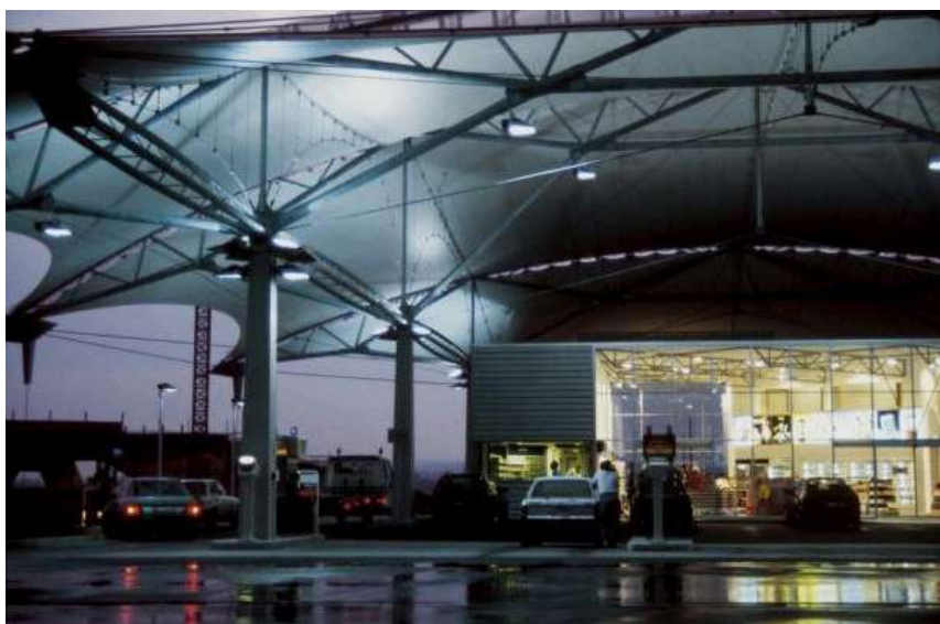
Figura 5.6 Visão sob cobertura onde se percebe os alinhamentos abertos das costuras da membrana de PVC branco e transparente de um pátio de um posto de gasolina em Wanlin na estrada the Brussels-Luxembourg - E411 highway, projeto do escritório Samyn and Partners, disponível em http://www.samynandpartners.be/ (05/07/2007).
