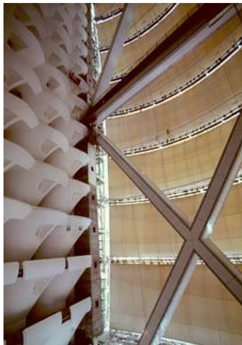
Figura 1.28 Vista interna da estrutura de sustentação e da fixação da membrana da fachada do Burj al Arab Hotel projeto de David Dexter Associates, disponível em http://www.ddassoc.co.uk/people/ddexter.shtml# (06/07/2007).
