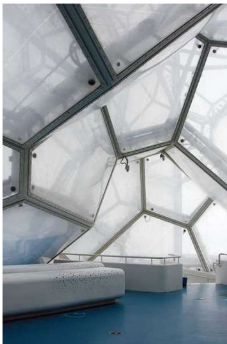
Figura 5.66 A compatibilidade da forma estrutural com o ETFE no Cubo Aquático (PTW apud GONCHAR, 2008).
