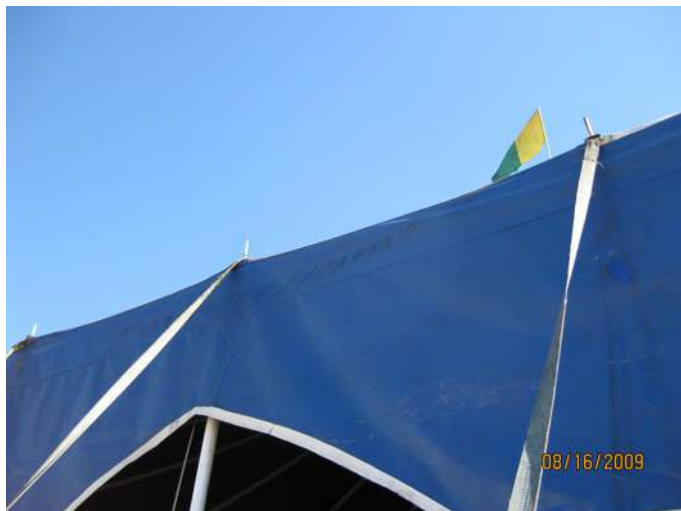
Figura 6.55 Vista do topo dos mastros laterais (da autora, 2009).
