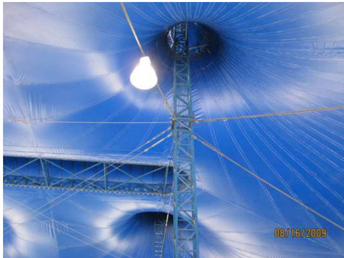
Figura 6.73 Vista interior dos tops e enrugamentos em cruzamento de costuras (da autora, 2009).
