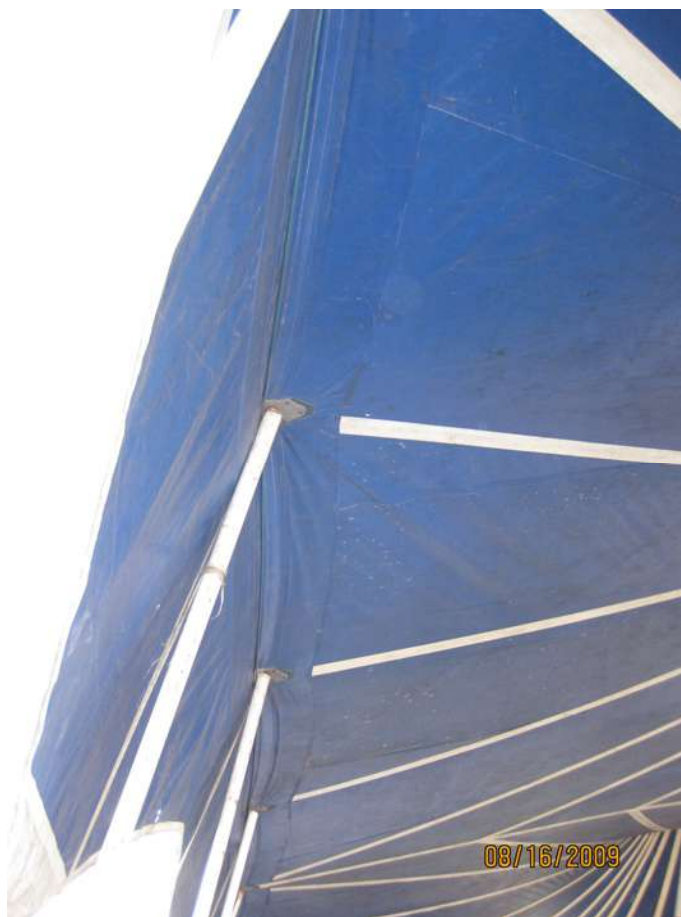
Figura 6.54 Vista inferior dos mastros laterais alinhamento coincidente com as costuras das membranas (da autora, 2009).
