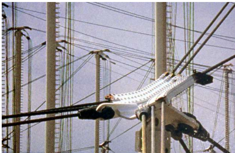
Figura 5.104 Instalação da estrutura de cabos para sustentação do Georgia Dome em Atlanta (Disponível em http://www.columbia.edu/cu/gsap/BT/DOMES/GEORGIA/ em 08/08/2001).
