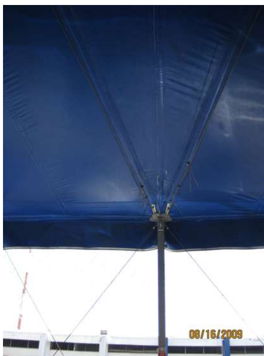
Figura 6.66 Vista dos cabos de contraventamento (da autora, 2009).
