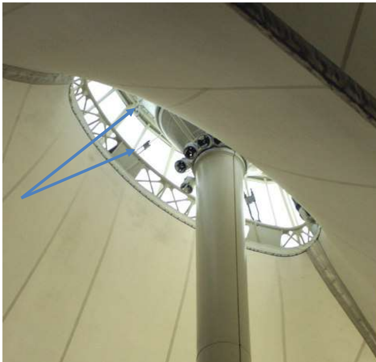
Figura 5.234 Anéis tensores no Aeroporto de Denver disponível em www.howardwill.com/Photos/Pueblo/PhotosPueblo.htm em 16/07/2009.
