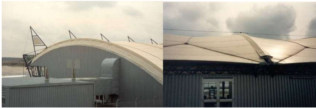
Figura 5.121 Vista da cobertura de um galpão no Aeroporto de Lyon Satolas, construído em 1991, cobertura destinada para invernos intensos e verões moderados em têxtil estrutural, disponível em TENSINET( 2007).
