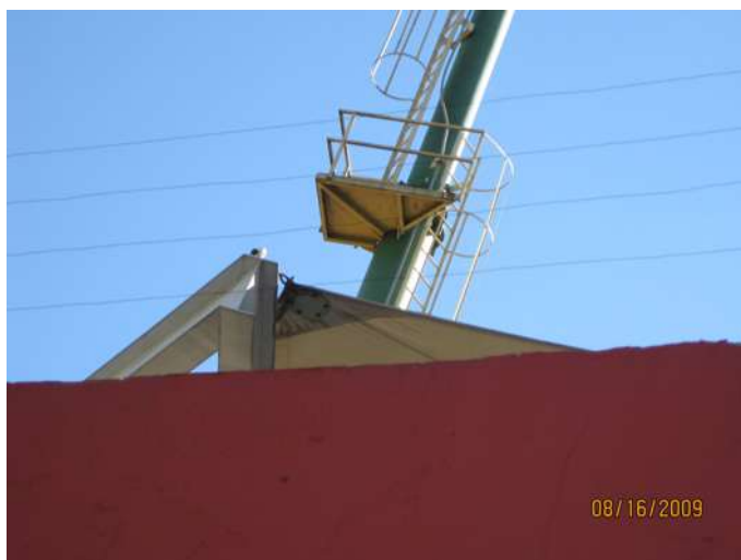
Figura 6.38 Vista da conexão de extremidades membrana-viga no canto da cobertura (da autora, 2009)
