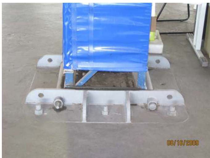
Figura 6.78 Vista da base de um dos mastros principais, soldado na base de chapa de aço (da autora, 2009).
