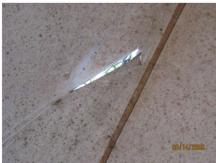
Figura 6.14 Vista interna da tenda com membrana com pigmentação de degradação e rasgo com demarcação de escoamento de águas (da autora, 2009)
