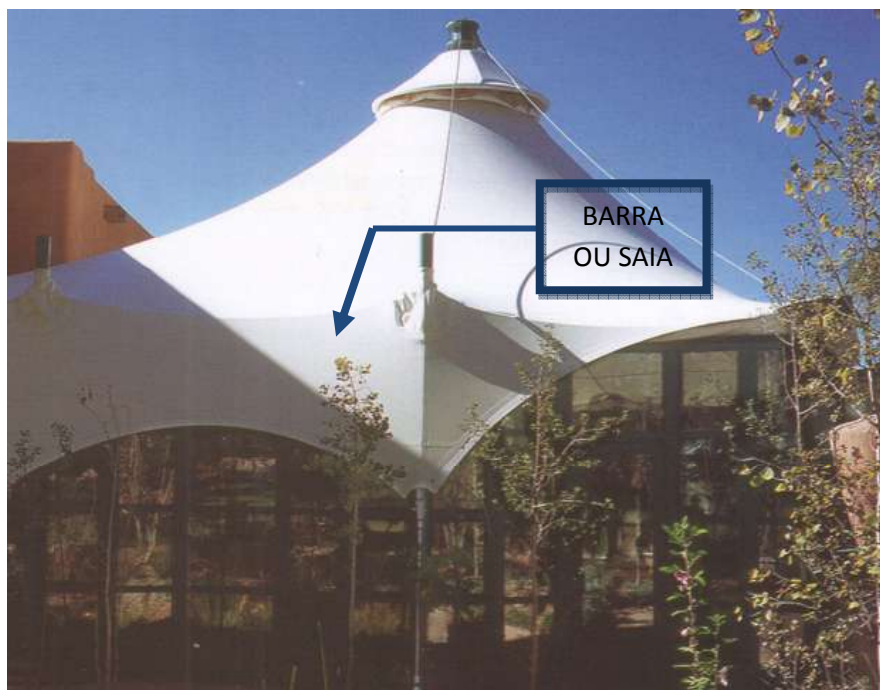
Figura 5.135 Término com barra ou saia sobre vedação externa na obra El Monte Resort (HUNTINGTON, 2004).
