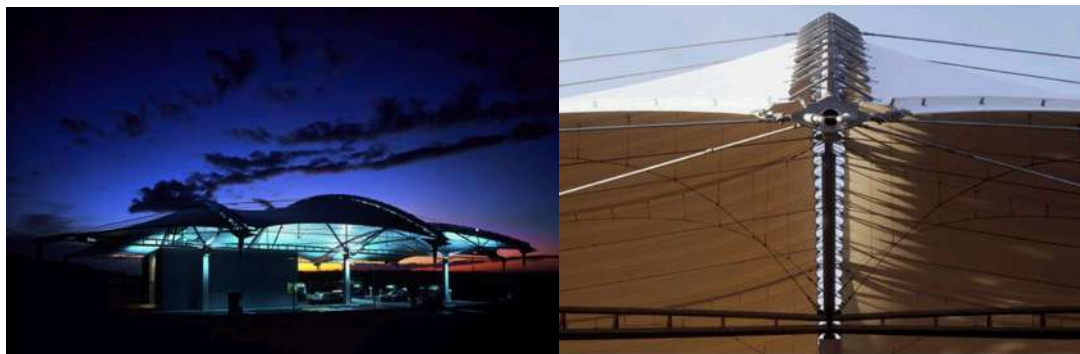
Figura 5.5 Vista das costuras abertas no período noturno e em detalha a luz do dia da cobertura em PVC branco e transparente de pátio de um posto de gasolina em Wanlin na estrada the Brussels-Luxembourg - E411 highway, projeto do escritório Samyn and Partners, disponível em http://www.samynandpartners.be/ (05/07/2007).
