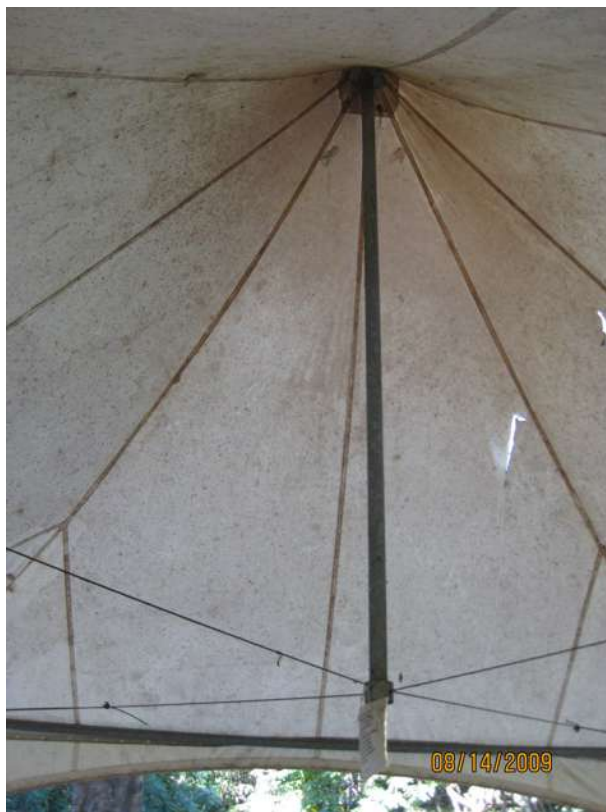
Figura 6.23 Vista do mastro flutuante apoiado diagonalmente por cabos (da autora, 2009)
