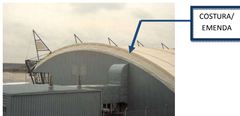
Figura 5.137 Vista da cobertura de um galpão no Aeroporto de Lyon Satolas, costura sobre vedação metálica externa, disponível em TENSINET( 2007).
