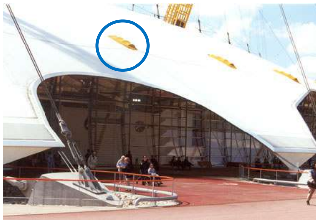
Figura 5.184 Fechamento externo do ponto de ligações cabo-mastro com esticadores no Millennium Dome, disponível em http://www.tensinet.com/database/viewProject/3782.html em 17/07/2009
