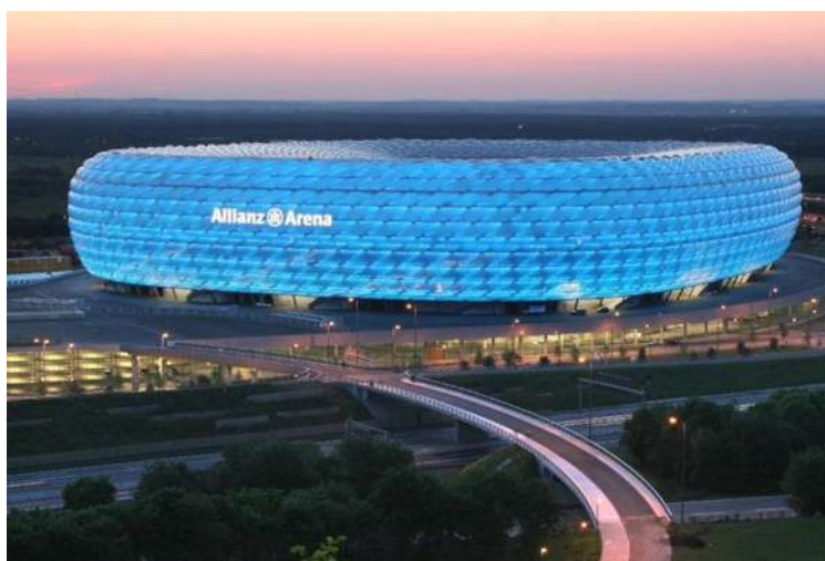
Figura 5.7 O estádio Allianz Arena sob controle luminotécnico em que ETFE pela sua transparência permite mudanças de cores devido à iluminação artificial instalada, disponível em http://commons.wikimedia.org/wiki/Image:Allianz_Arena_Diongillard.jpg (04/07/2007).
