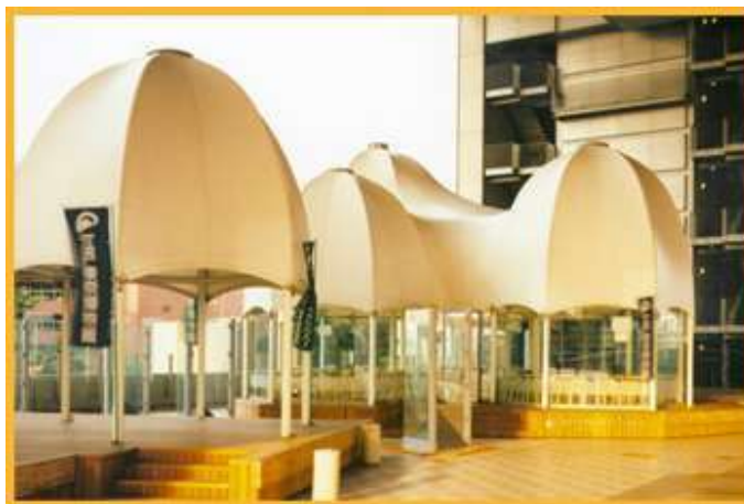
Figura 5.47 Cobertura em PTFE no Museu de Edo, Japão (SKYSPAN, 2001).
