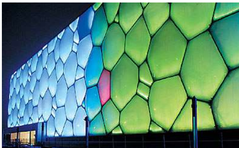
Figura 3.14 Vista noturna com controle luminotécnico do Cubo de Beijing, disponível em http://www.china.org.cn/english/environment/241755.htm (27/02/2008).
