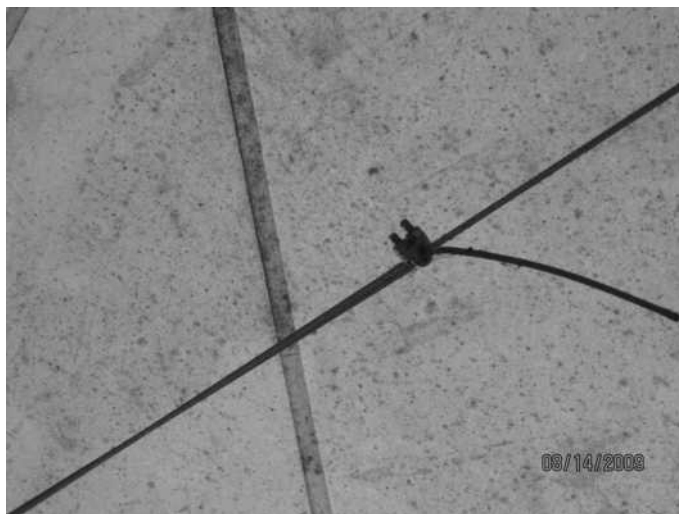
Figura 6.15 Vista de emenda de cabo em laço e com grampo no término (da autora, 2009)
