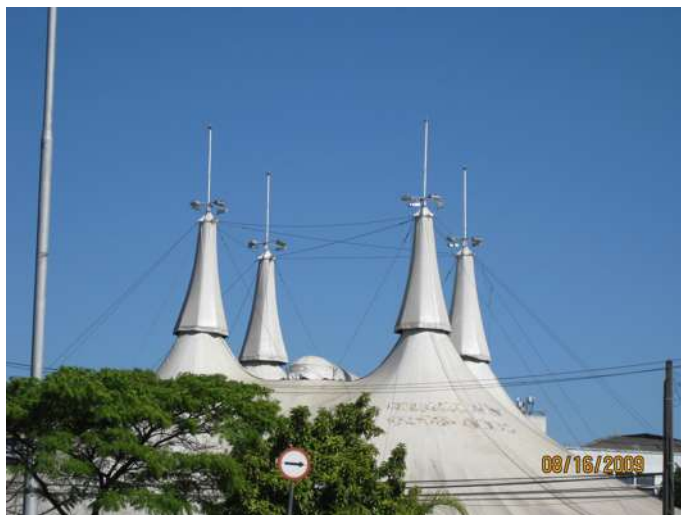
Figura 6.58 Vista dos cabos de travamento dos mastros principais (da autora, 2009).
