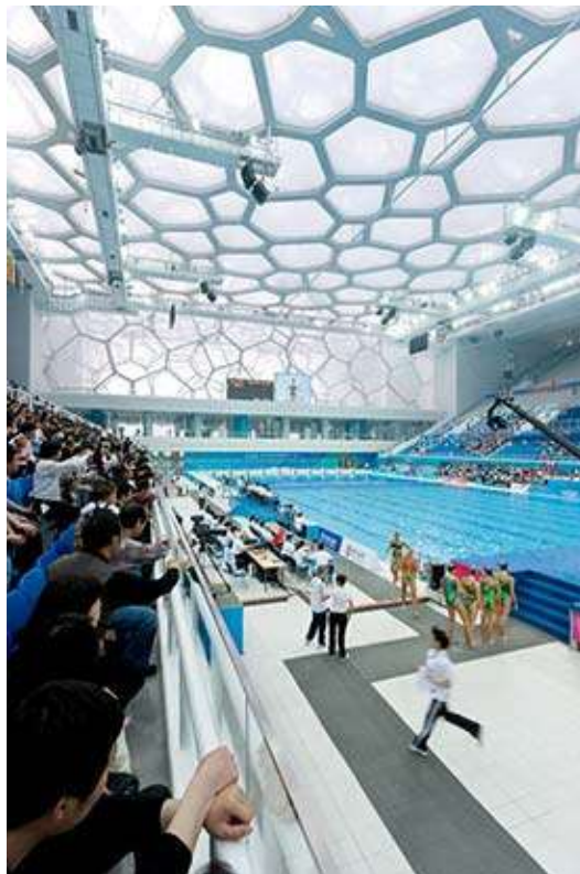
Figura 5.62 No interior do Cubo Aquático: durante o dia o sistema em ETFE oferece luz solar difusa para a iluminação ( Iwan Baan apud GONCHAR, 2008).
