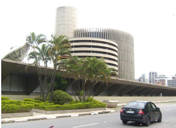
Figura 83: Centro de Processamento de Dados do Banco do Brasil, na Rua Verbo Divino – década de 1970.
