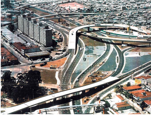
Figura 93: Mini-Anel Viário – Entroncamento com a Via Anchieta – Complexo Viário E.E.Mackenzie
