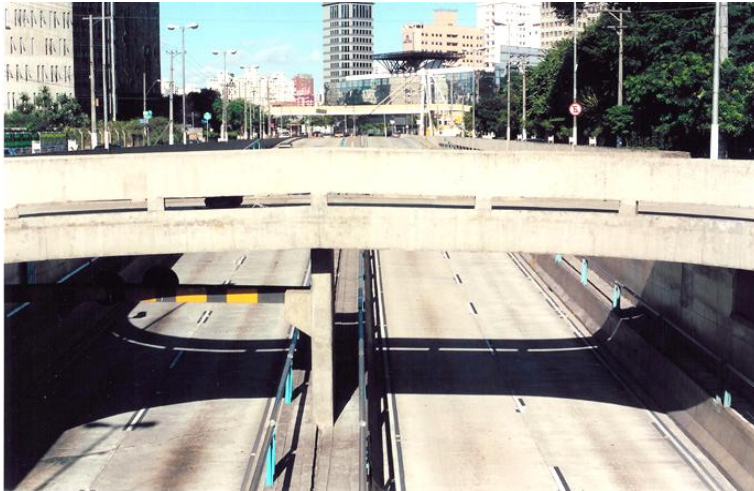
Figura 108: Embocadura do Túnel na Av. Juscelino Kubitschek. Fonte: Foto tirada pelo autor (2001)
