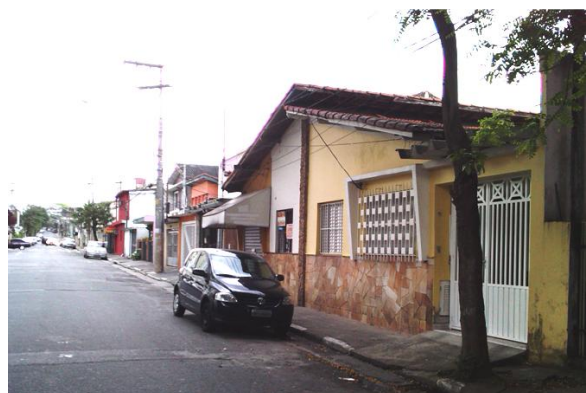
Figura 87: Chácara Santo Antônio - Aspecto da vizinhança Fonte: foto tirada pelo autor (2009)
