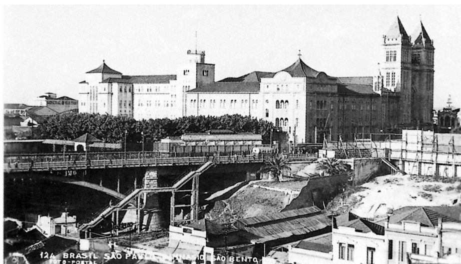
Figura 28: Obras do Viaduto Santa Ifigênia, executado entre 1909-1913.
