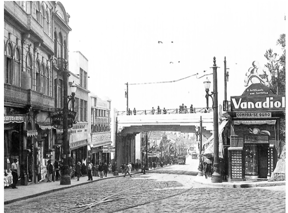
Figura 25: Viaduto Boa Vista sobre a Rua General Carneiro.
