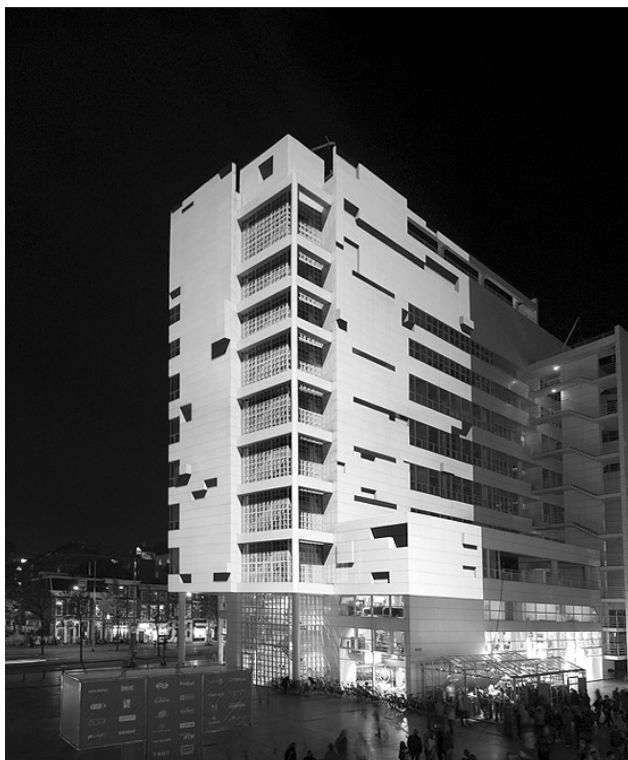
Figura 11 – instalação urbana em Haia
