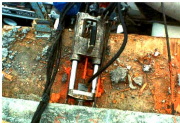
FIGURA 2.32 – Macaco Hidráulico
