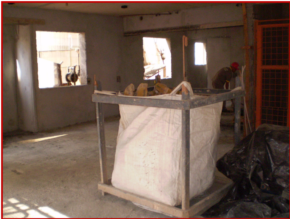
Figura 4.40 - Uso de bags nos pavimentos que estão realizando serviços que geram muitos resíduos de papelão ou plástico
