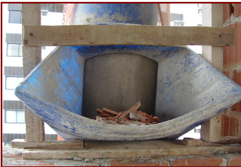
Figura 2.5 - Dispositivo de coleta inicial com tubo coletor de resíduo Classe A Fonte: AMBITEC
