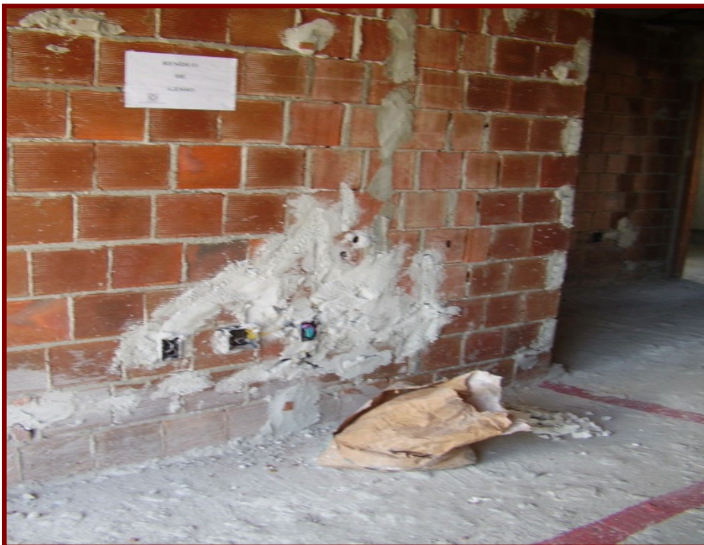
Figura 2.4 - Marcação no piso para acondicionamento inicial do resíduo Classe A Fonte: AMBITEC.
