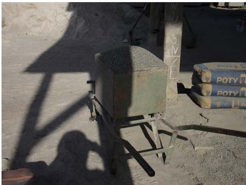
Figura 2.7 – Transporte interno da areia artificial
