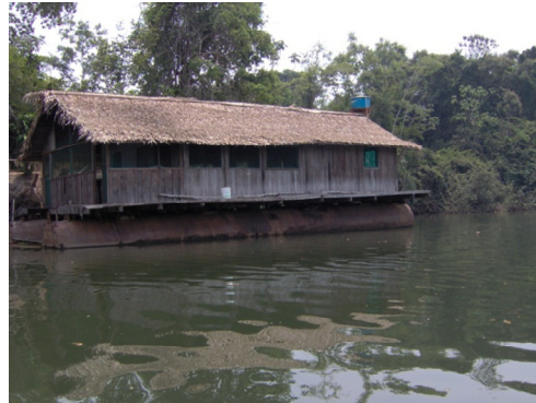
Foto 8: Casa de apoio de uma das pousadas, próxima à foz do rio Ximari
