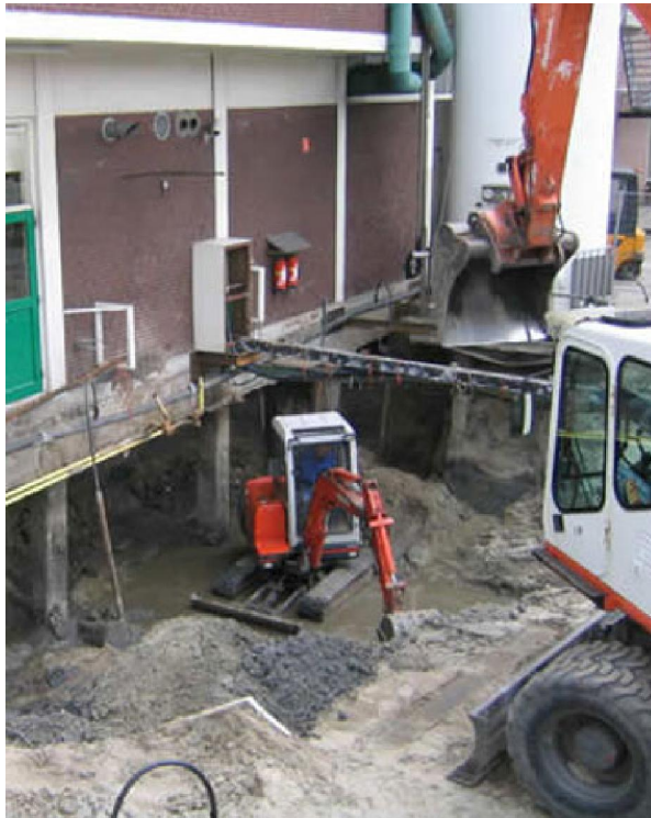
FIGURA 1 – RETIRADA DE SOLO CONTAMINADO PARA REMEDIAÇÃO (KWA, 07/10/2008)
