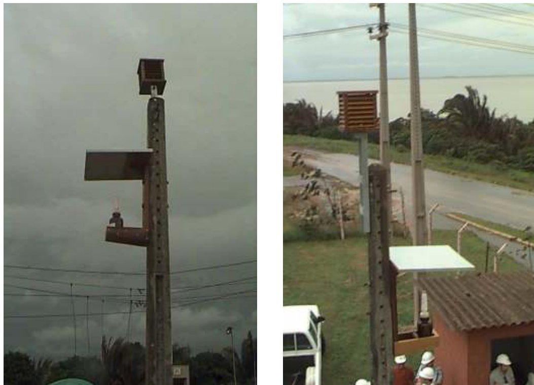
FIGURA 15. COLETORES DE COMPOSTOS DE ENXOFRE E CLORETOS NA SE ITAQUI
